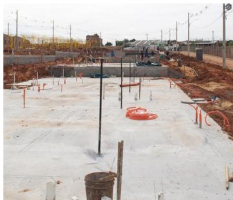
**Etapa 1:** radier e esperadas instalações elétricas e hidráulicas
