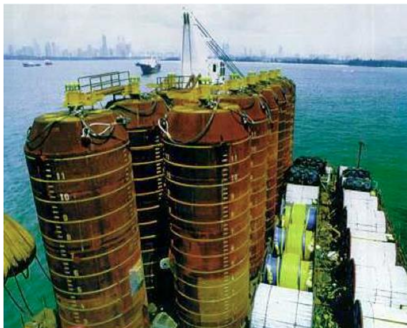
Figura 4: Estacas de sucção (RANDOLPH et al, 2005).
