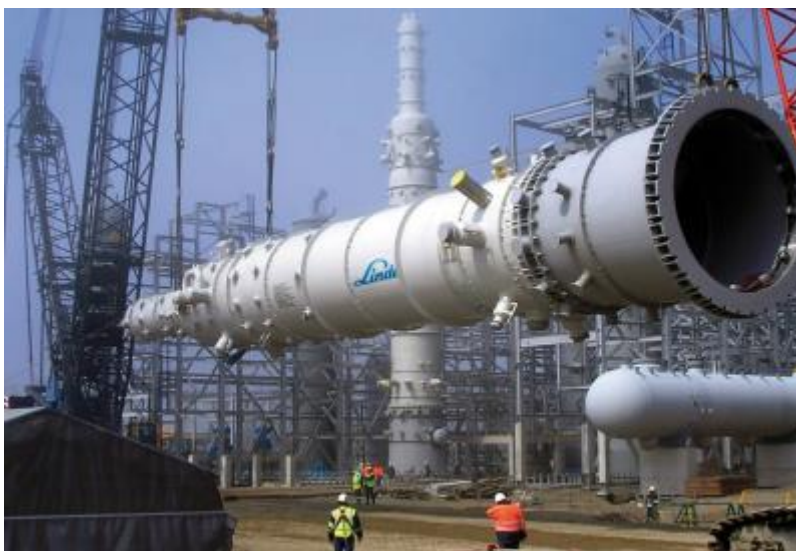
Figura 1.1: Trocador de calor de tubo espiral para a liquefação de gás natural. Fonte: LINDE (2015)
