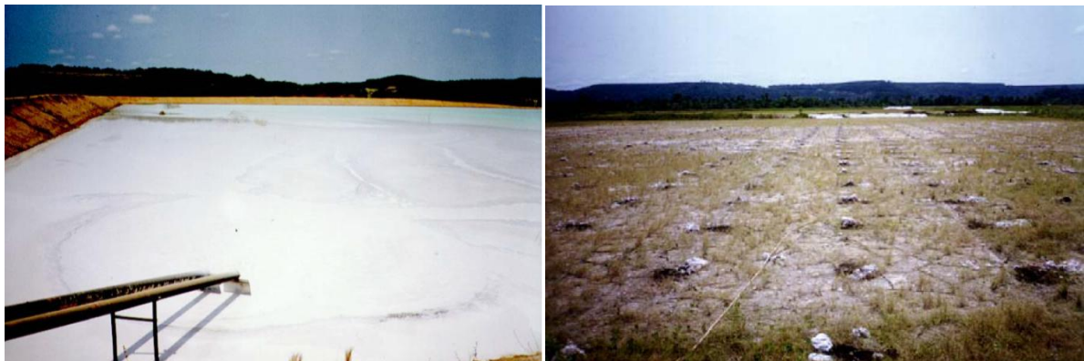
Figura 12 - Bacia de decantação do lodo de caulim (a) bombeamento do lodo para as lagoas (b) lagoa de decantação após secagem (BARATA, 1998)
