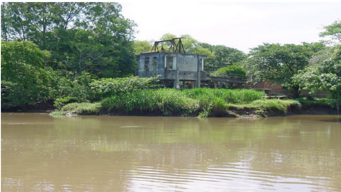
Figura 4.31 - EA15: Rio dos Sinos (captação da CORSAN para o abastecimento do Município de Campo Bom).
