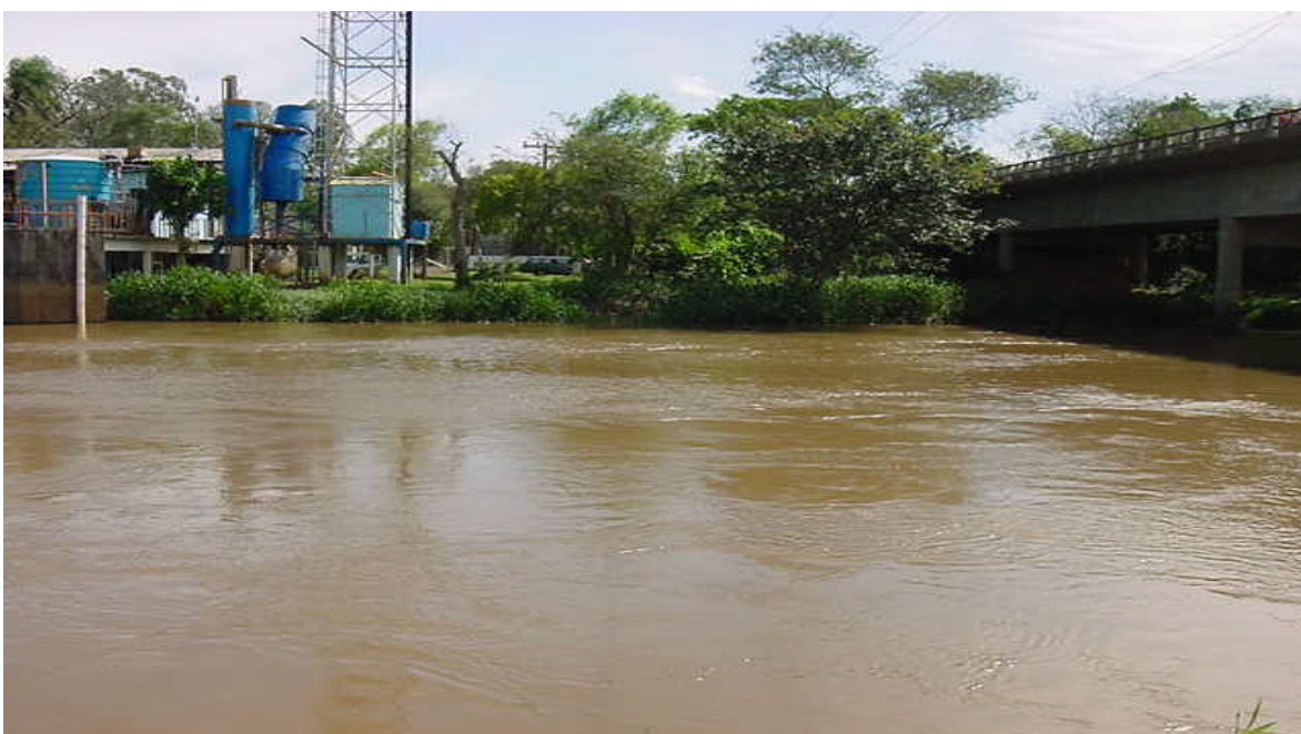
Figura 4.32 - EA 16: Rio dos Sinos (captação da COMUSA para o abastecimento do Município de Novo Hamburgo)
