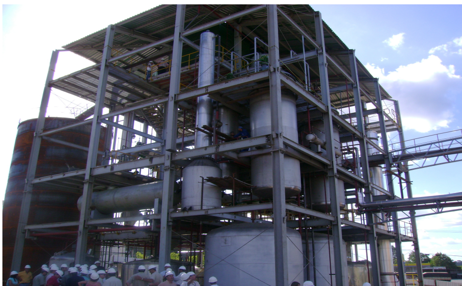
Figura 27: Instalações da U2.
