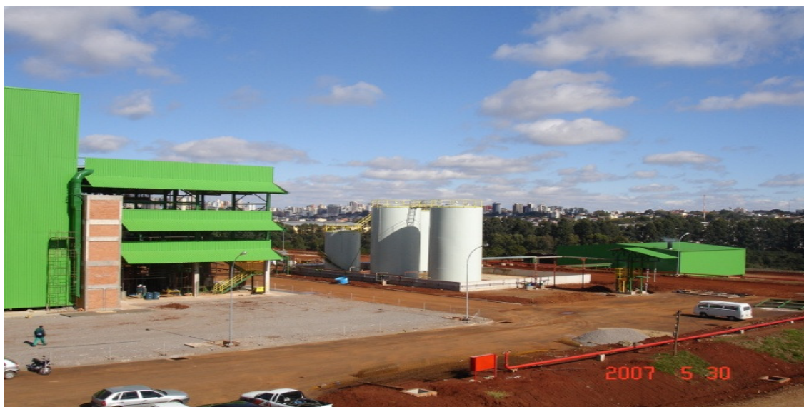
Figura 26: Instalações da U1.
