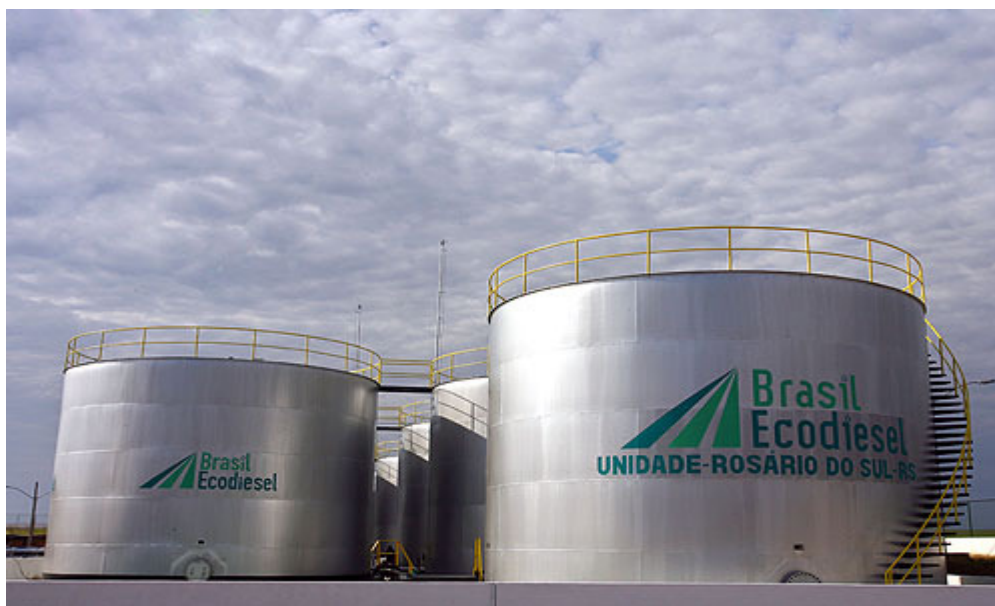
Figura 28: Instalações da U3 em Rosário do Sul/RS.
