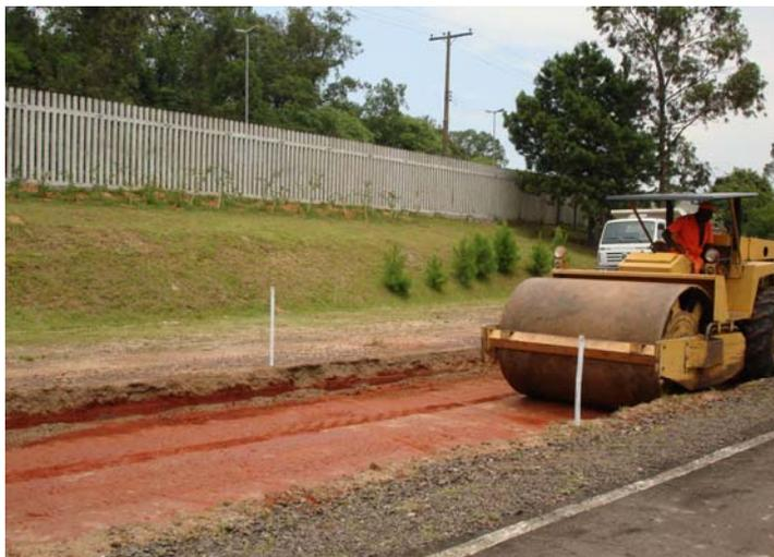
Figura 5.22: Regularização da camada argilosa do local do experimento desta pesquisa
