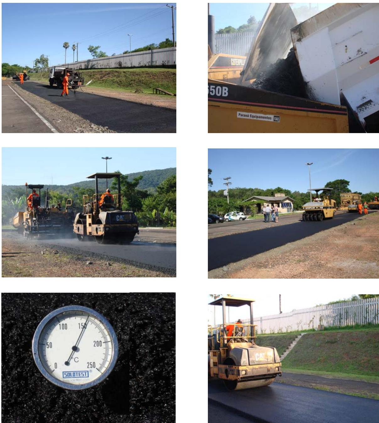
Figura 5.29: Procedimentos executivos da camada de módulo elevado da pista experimental desta pesquisa
