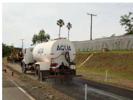
Figura 5.25: Distribuição e compactação da brita graduada no local do experimento desta pesquisa
