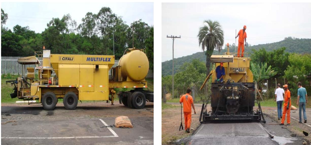
Figura 5.34: Execução da camada de rolamento da pista experimental desta pesquisa
