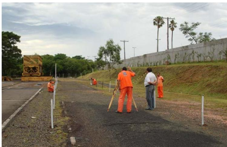
Figura 5.19: Levantamento topográfico no local da pista experimental deste estudo
