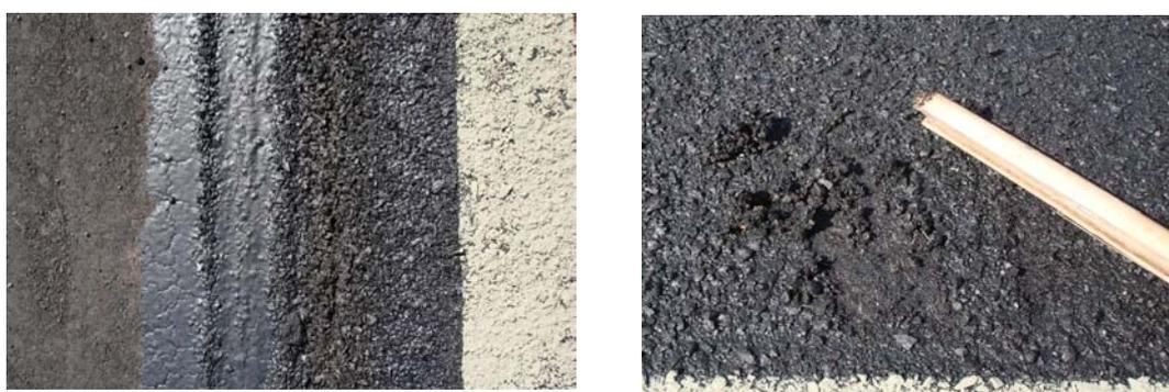
Figura 5.36: Deficiências observadas no microrrevestimento asfáltico da pista experimental desta pesquisa
