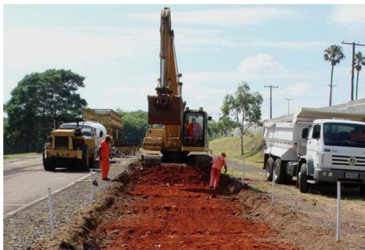
Figura 5.21: Aspecto da camada de argila após escavação no local do experimento desta pesquisa
