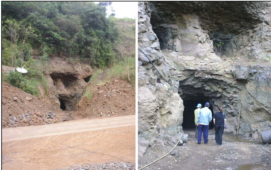
Figura 15. Exemplo de explorações realizadas em cotas erradas do derrame basáltico. Dos 2 níveis abertos, apenas o inferior possui mineralização.
