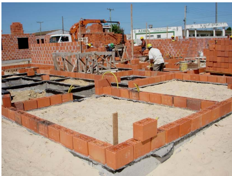
Figura 60: assentamento da primeira fiada sobre as vigas de baldrame
