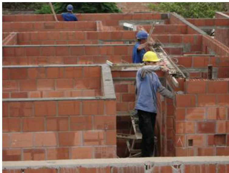
Figura 54: camada de regularização sobre as paredes da edificação
