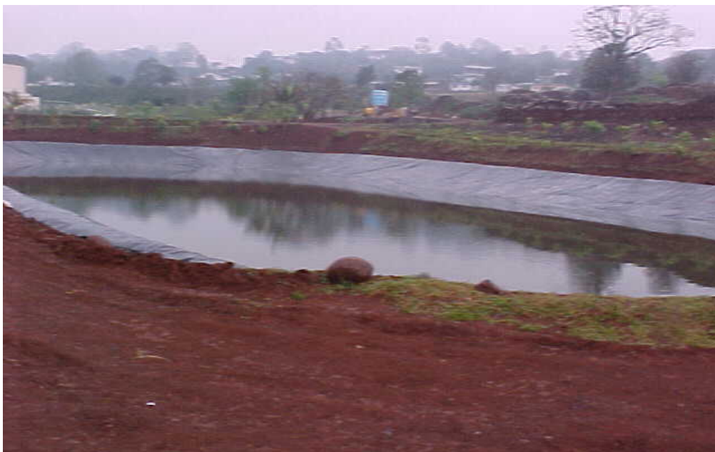
Figura 31: Lagoa 4 impermeabilizada com geomembrana
