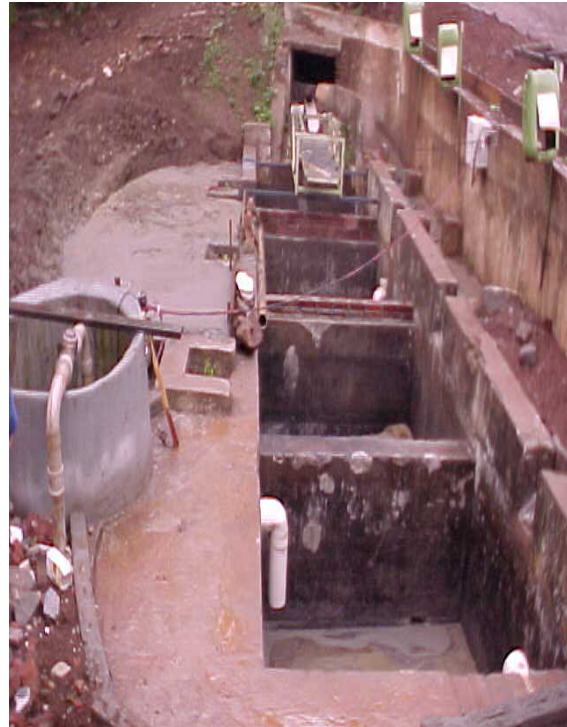
Figura 30: Esterqueira e tanque de captação do percolado da esterqueira
