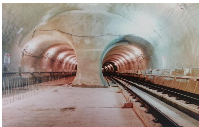
Figura 12: Revestimento de concreto projetado no túnel da Estação Jardim São Paulo (Comitê Brasileiro de Túneis, 2006).
