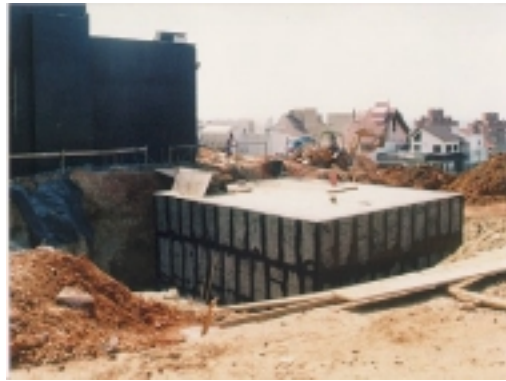
Figura 5.24 – Trabalho em progresso: execução do reservatório enterrado.
