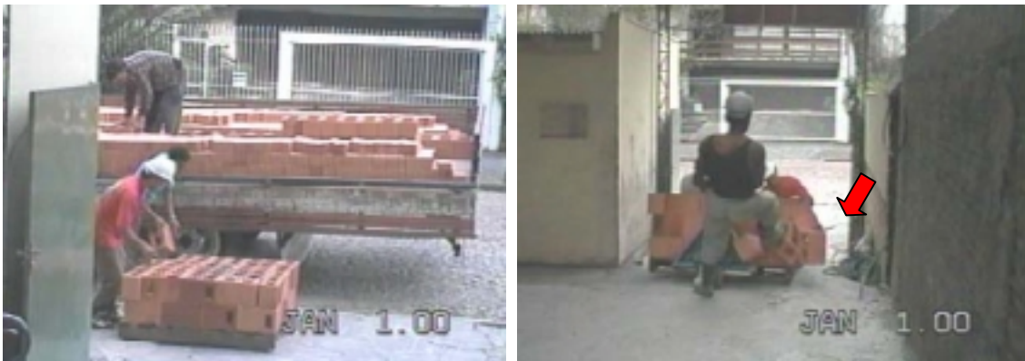
Figura 5.4 – Blocos cerâmicos: (a) Descarregamento manual do caminhão (b) Transporte com paleteira para o estoque
