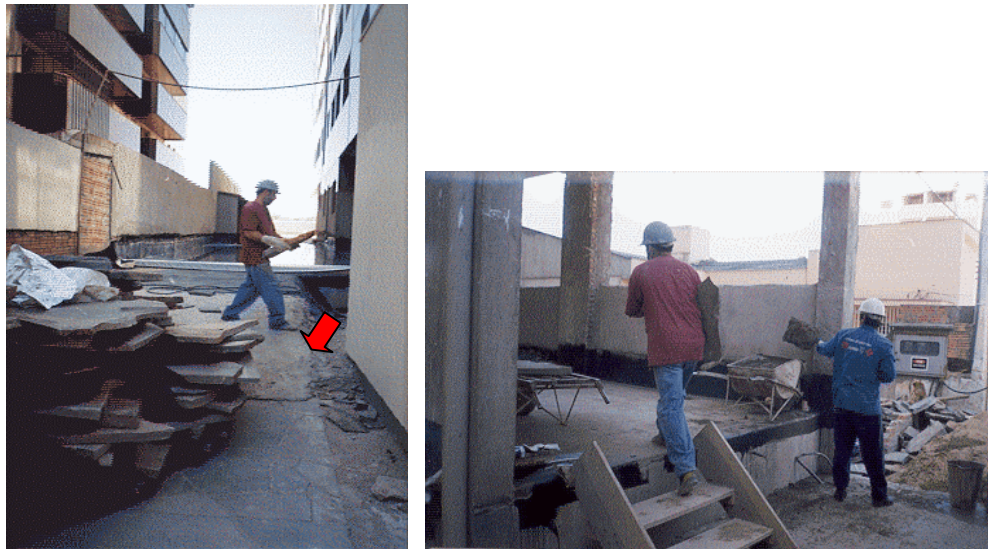
Figura 5.18 – Atividades do processo de assentamento de piso basáltico: (a) estoque do material e transporte para o carrinho (a seta indica a rampa); (b) um dos operários sobe escada transportando o basalto e o outro transporta argamassa para o carrinho
