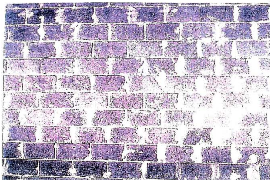
FIGURA 6.32 - Paredes executada com blocos de EVA
