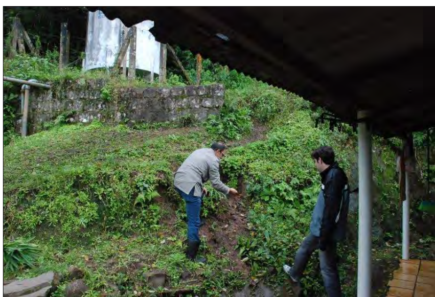
Fotografia 36- Monitoramento da Defesa Civil em ravina na Vila Bilibio no ano de 2011 e que se agravou no ano de 2014.
