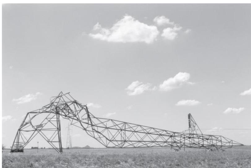
Figura 9: falha de uma estrutura de LT na Austrália (HOLMES, 2008)
