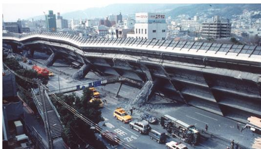
Figura 5.3: Liquefação de solo de fundação de via expressa de Hanshin devido ao terremoto de Kobe, Japão, 1995 (fonte: U.S. Department of Transportation)
