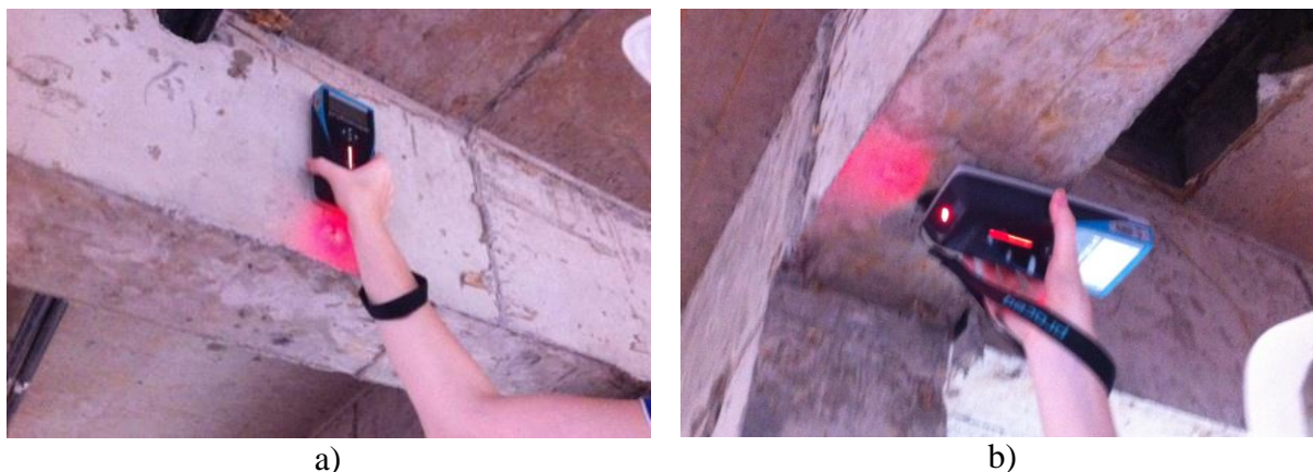
Figura 16 – Medição de cobertura das vigas: a) lateral da viga; b) fundo da viga.
