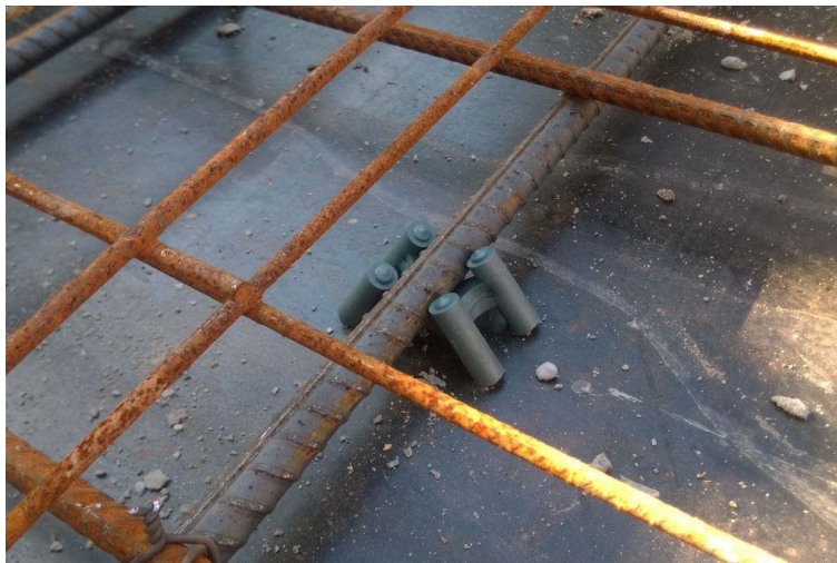
Figura 27 - Deformação do espaçador diante da carga em serviço.
