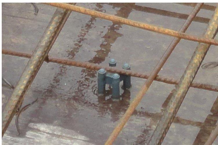
Figura 2 - Espaçador utilizado para separar armadura da fôrma.
