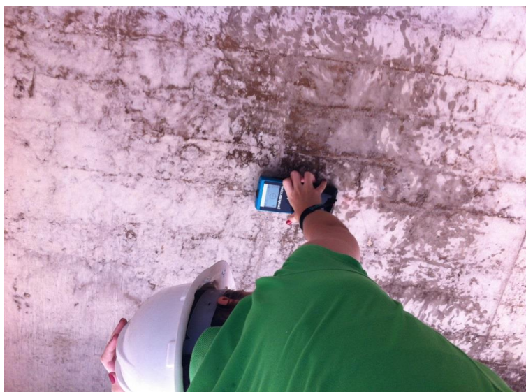
Figura 15 - Medição do cobrimento das armaduras positivas em fundo de laje com auxílio de pacômetro.
