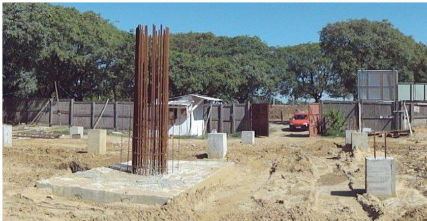
Imagem 4 – Obras da segunda fase 82 (construção das fundações da Sala Sinfônica).
