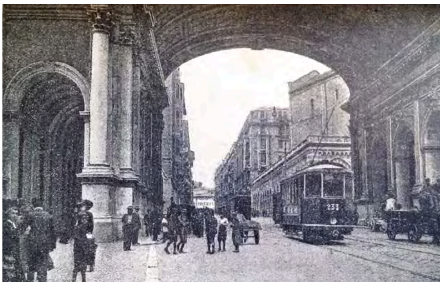
Figura 155 - Viaduto da Via Andrea Podestà , construído com um arco monumental, sobre a Via XX de Settembre , em Gênova, segundo Caccia
