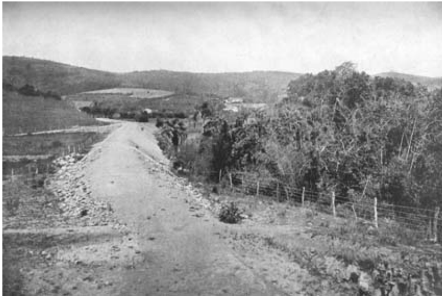
Figura 97 - Aterro em trecho do leito da Estrada de Ferro de Porto Alegre à Viamão, cujos estudos foram feitos pelo Instituto de Engenharia
