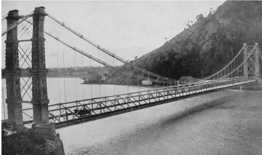
Figura 94 - “A tecnica allemã no Brasil”: a Ponte de São Vicente, segundo Funke
