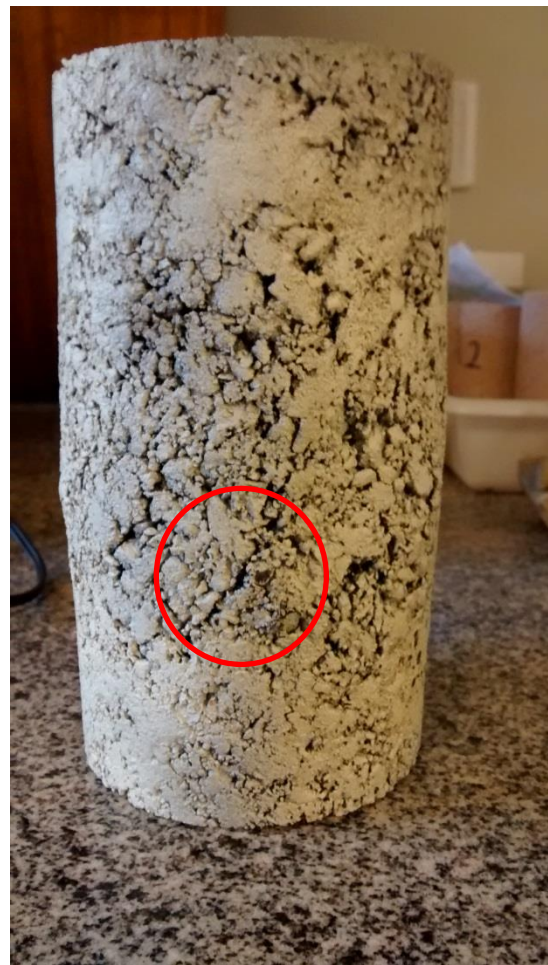
Figura 38: trinca no CP rompido
