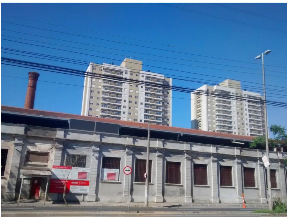
Figura 22 - Antiga fábrica da Companhia Fiação e Tecidos Porto Alegreense – Fiaterci, após projeto de revitalização com manutenção da fachada original (transformada em lojas) e torres residenciais (ao fundo), entre as Avenidas Voluntários da Pátria e São Pedro, bairro São Geraldo.
