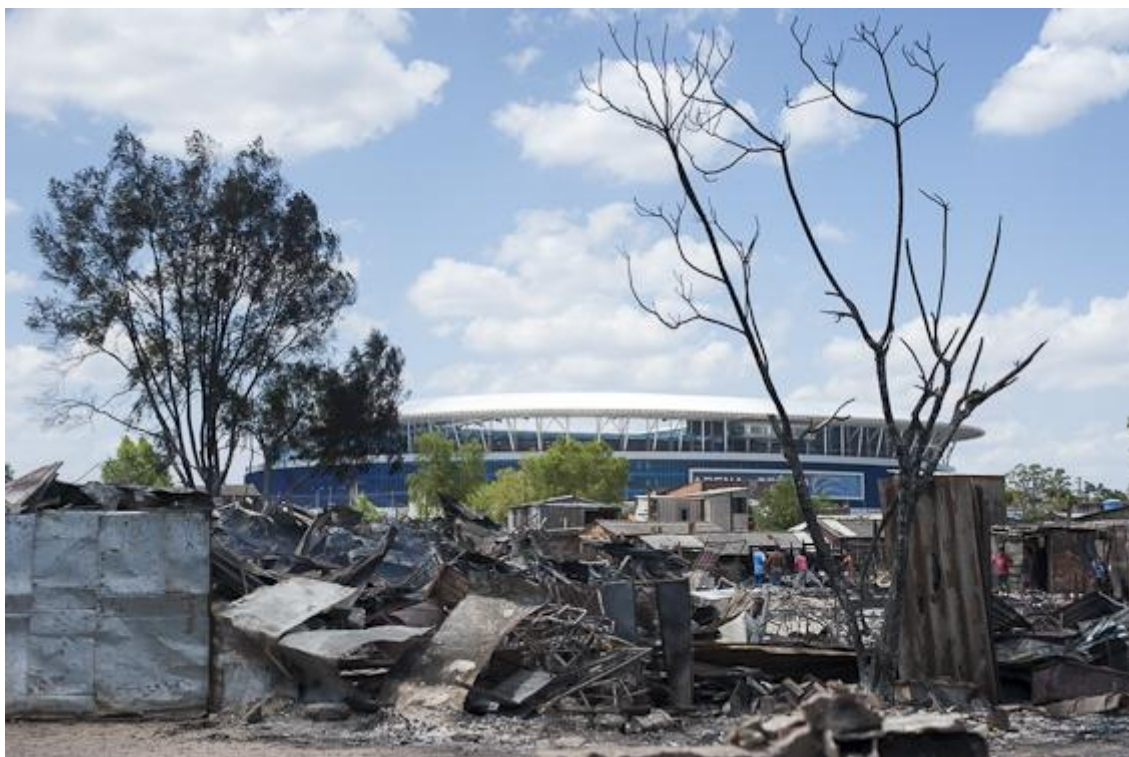
Figura 14 - Incêndio que deixou escombros na Vila Liberdade, com a Arena do Grêmio ao fundo, em 2013.
