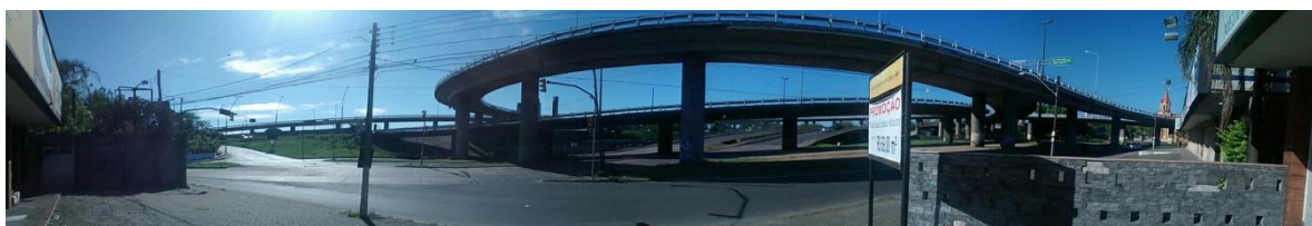
Figura 16 - Imagem panorâmica do entroncamento das avenidas Voluntários da Pátria e Sertório com a Avenida da Legalidade e da Democracia, próximo a Igreja Nossa Senhora dos Navegantes no bairro Navegantes. Alguns cidadãos utilizam o local como moradia. Fonte: Pedro Toscan, novembro de 2014.
