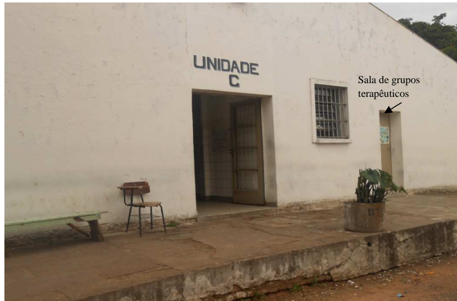
Figura 13 - Porta de entrada da Unidade de Tratamento C
