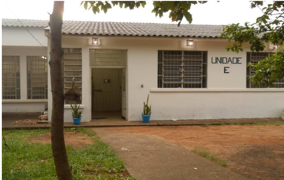
Figura 9 - Porta de entrada da Unidade de Tratamento E
