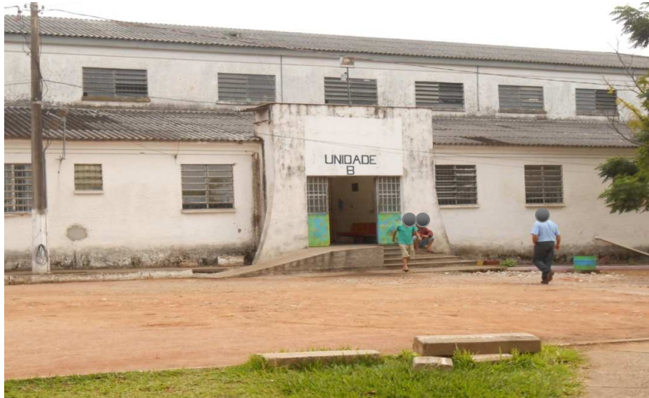
Figura 11 - Área externa da Unidade de Tratamento B
