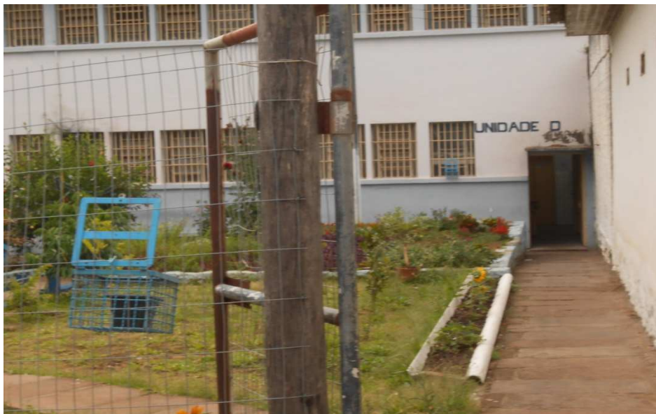
Figura 15 - Área externa da Unidade de Tratamento D
