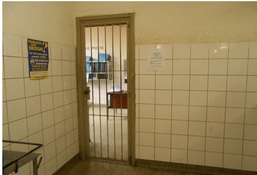
Figura 18 - Grades do posto de enfermagem (Unidade de Tratamento C)
