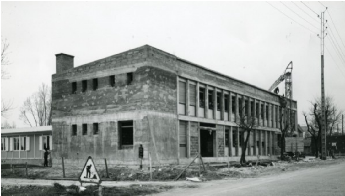
Extensão do Prédio da Agência Rhône-Méditerranée-Corse em torno de 1972
