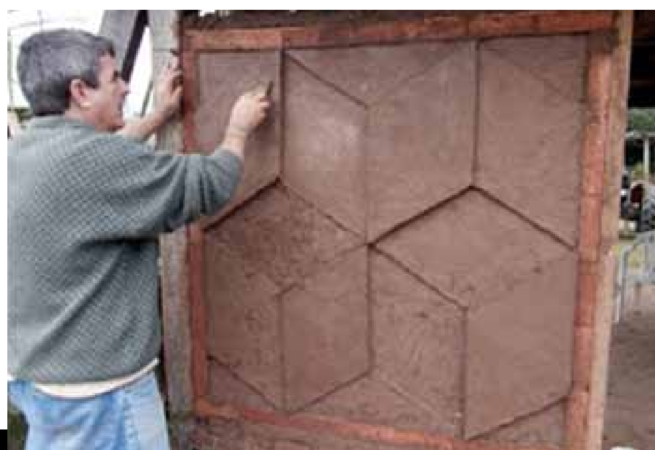
Painéis de pau-a-pique: trama de bambu, formada por linhas horizontais e verticais equidistantes, fixadas entre si, com suas extremidades presas aos alicerces, vigas e colunas da construção. Os espaços vazios formados pela trama são preenchidos com uma massa natural, constituída de terra, areia, palha, esterco e sumo de cactos
