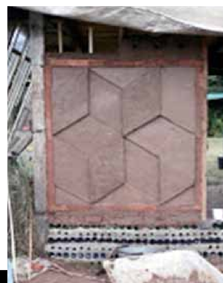
Painéis de pau-a-pique: trama de bambu, formada por linhas horizontais e verticais equidistantes, fixadas entre si, com suas extremidades presas aos alicerces, vigas e colunas da construção. Os espaços vazios formados pela trama são preenchidos com uma massa natural, constituída de terra, areia, palha, esterco e sumo de cactos
