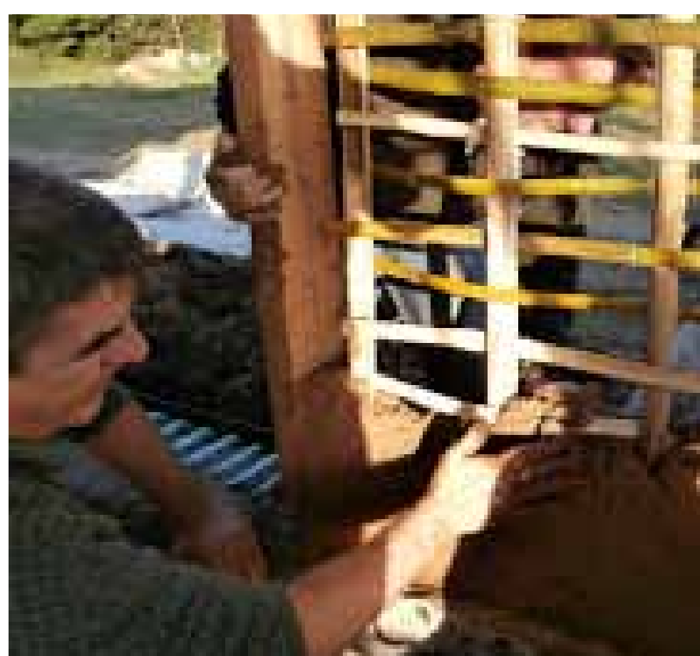
Painéis de pau-a-pique: trama de bambu, formada por linhas horizontais e verticais equidistantes, fixadas entre si, com suas extremidades presas aos alicerces, vigas e colunas da construção. Os espaços vazios formados pela trama são preenchidos com uma massa natural, constituída de terra, areia, palha, esterco e sumo de cactos
