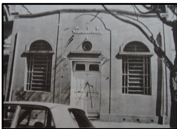
Figura 65: Fachada da Sinagoga Poilisher Farband
