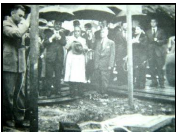
Figura 76: Lançamento da Pedra fundamental da SIBRA (1958)
