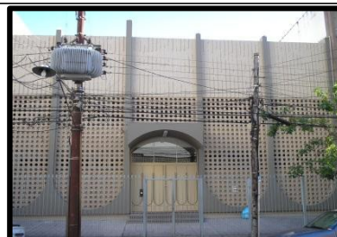
Sinagoga: Sociedade Beneficente Israelita de Socorros Mútuos- Linat Hatzedek Endereço: Bento Figueiredo, 55, Bom Fim COORDENADAS: 30° 02' 05,2"/51° 12' 32,5"
