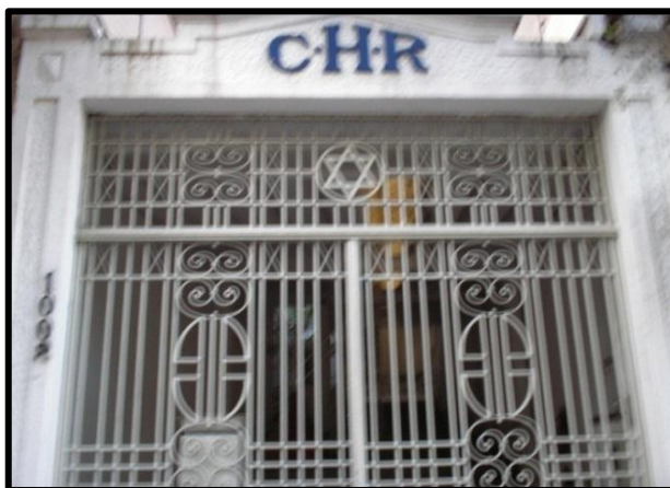
Figura 60: Fachada Externa do Centro Hebraico Rio-Grandense
