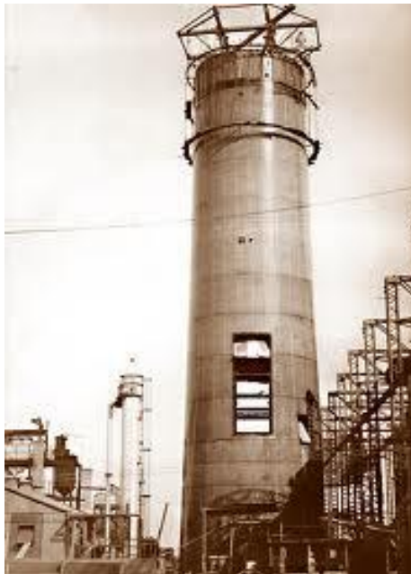
Figura 31 - Construção da Chaminé da Usina do Gasômetro
