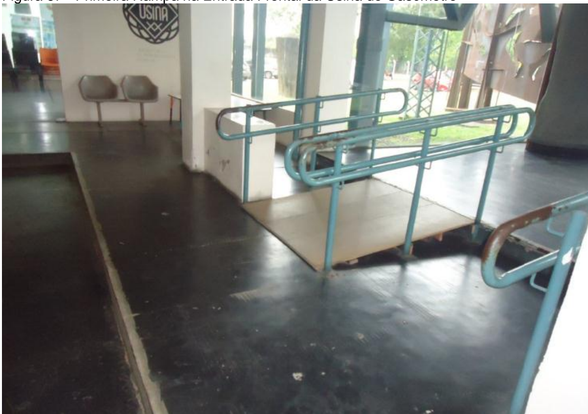
Figura 67 - Primeira Rampa na Entrada Frontal da Usina do Gasômetro
