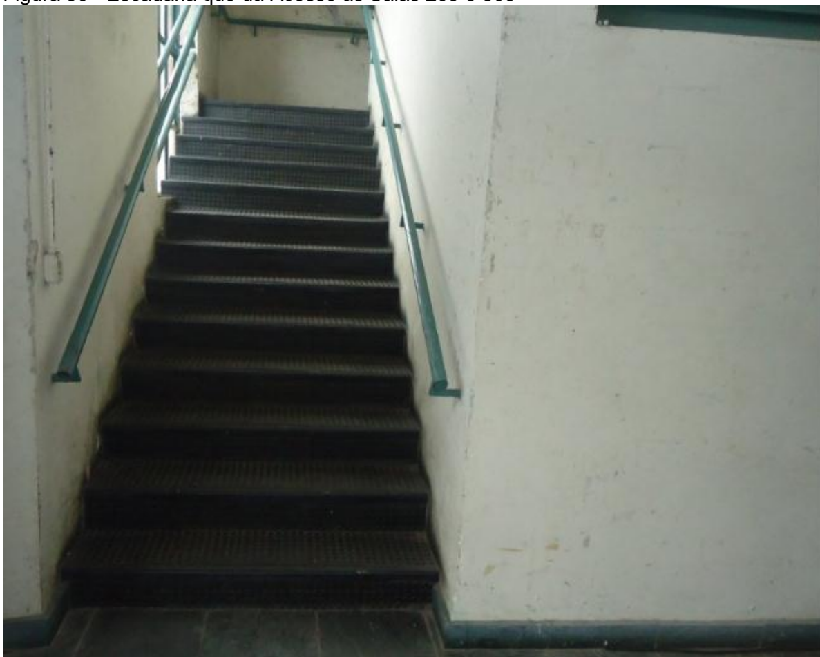
Figura 50 - Escadaria que dá Acesso às Salas 209 e 309
