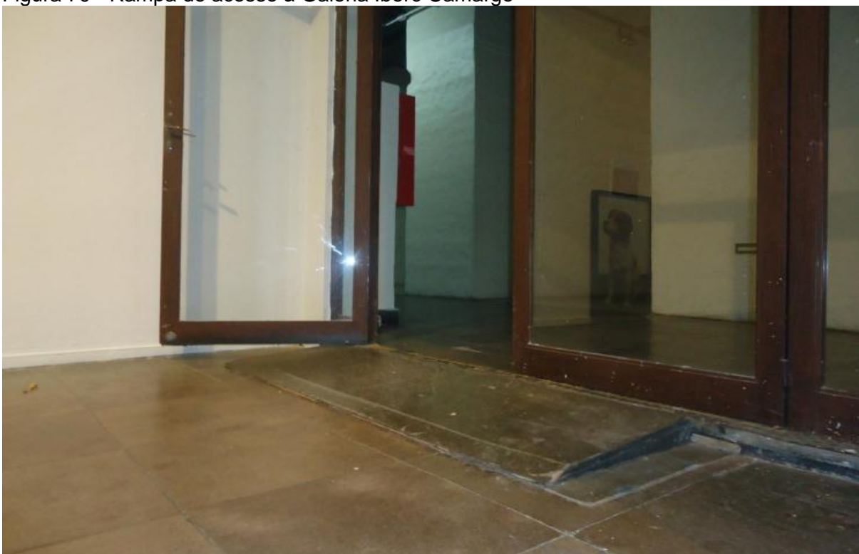
Figura 70 - Rampa de acesso à Galeria Iberê Camargo
