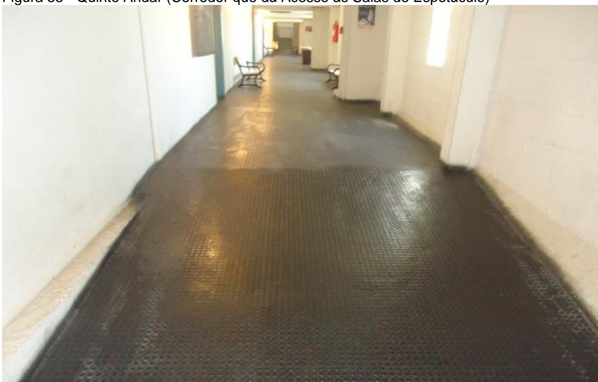
Figura 55 - Quinto Andar (Corredor que dá Acesso às Salas de Espetáculo)
