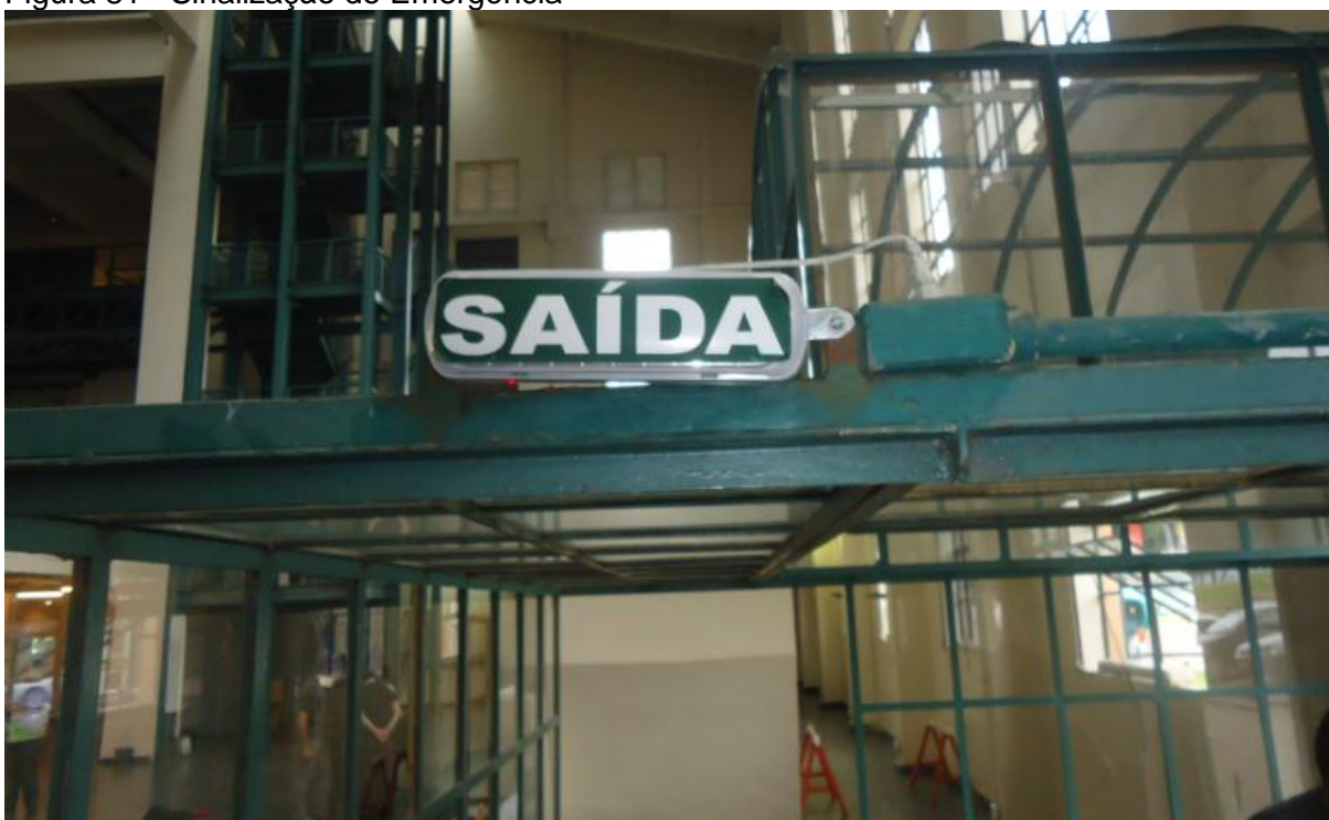
Figura 81 - Sinalização de Emergência
