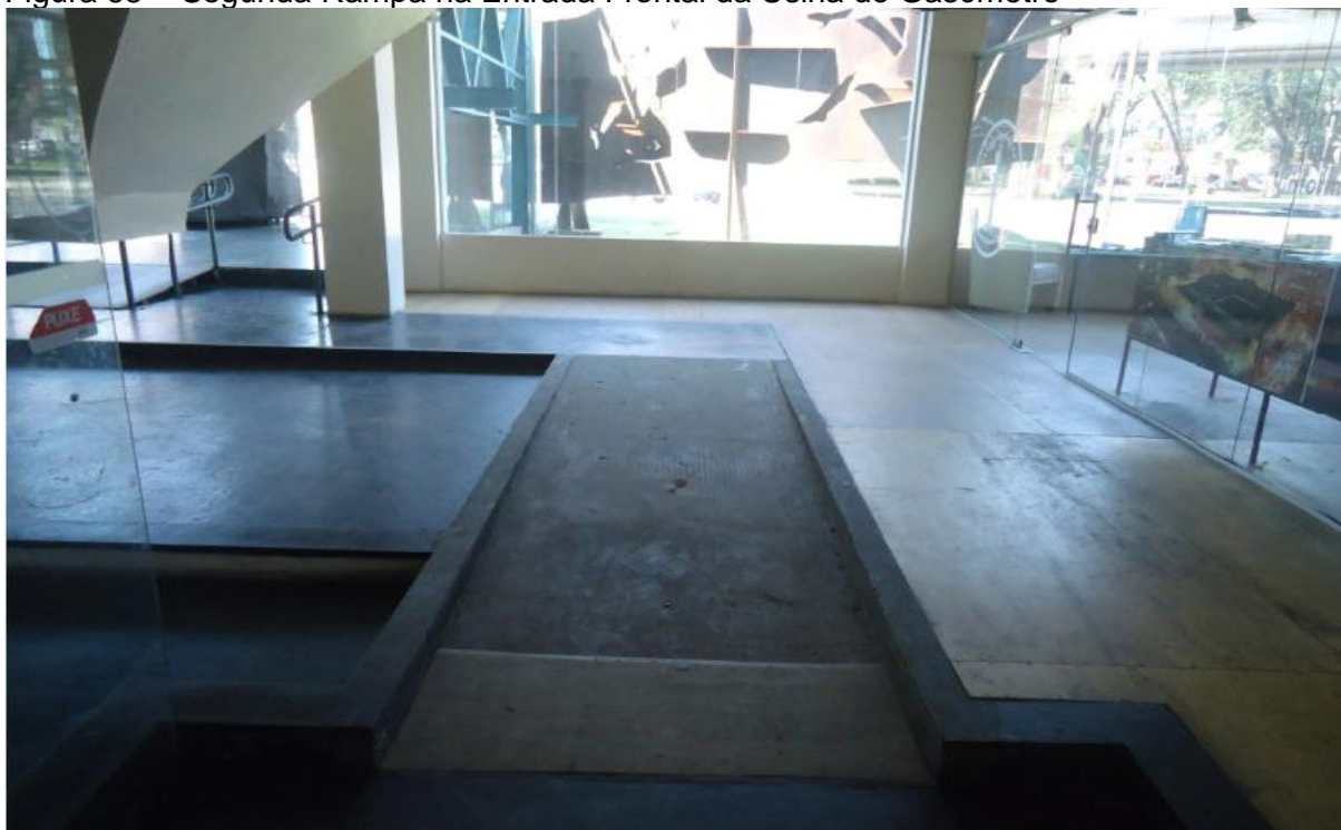
Figura 68 - Segunda Rampa na Entrada Frontal da Usina do Gasômetro
