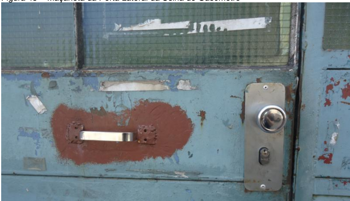
Figura 45 - Maçaneta da Porta Lateral da Usina do Gasômetro
