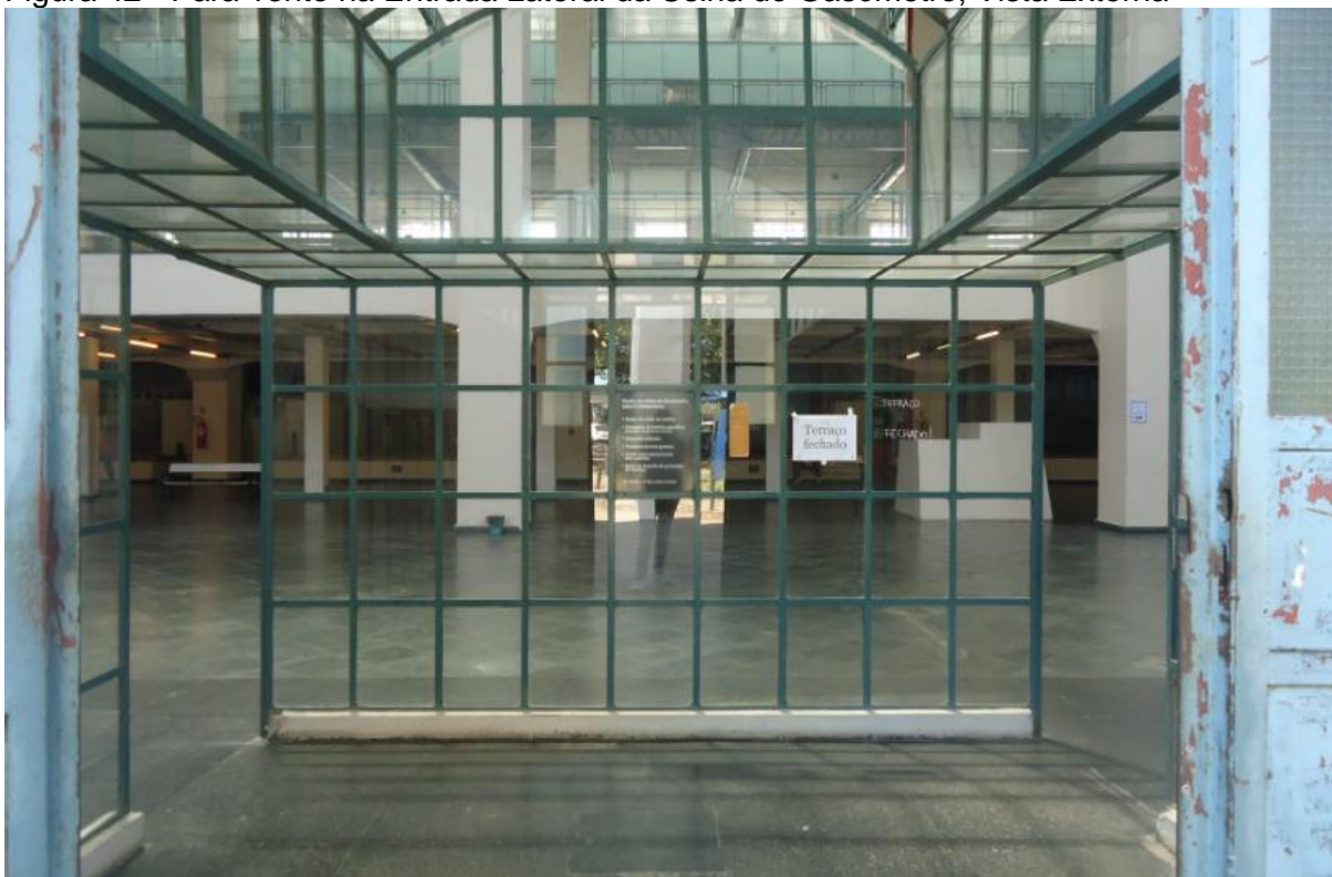
Figura 42 - Para-vento na Entrada Lateral da Usina do Gasômetro, Vista Externa
