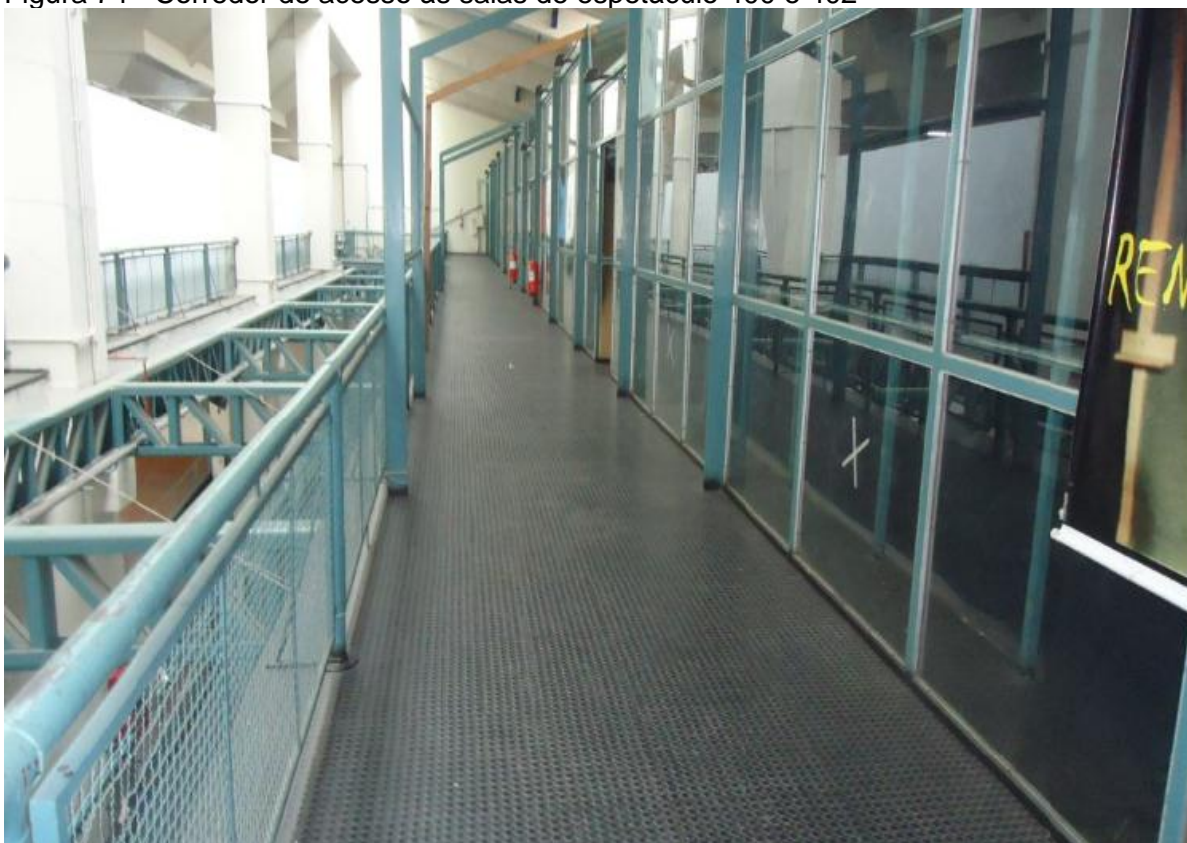
Figura 74 - Corredor de acesso às salas de espetáculo 400 e 402
