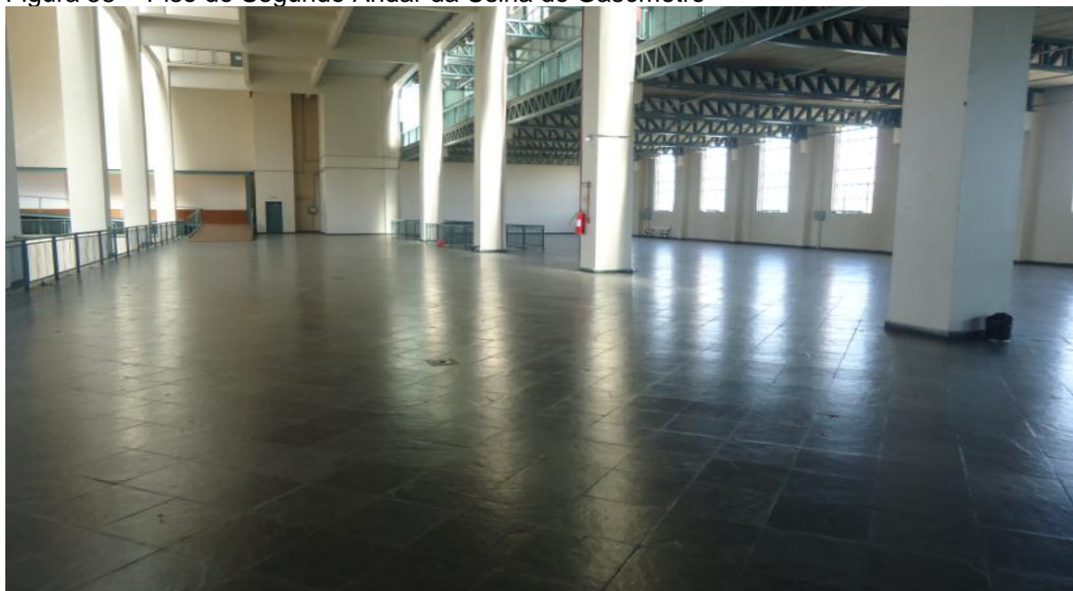
Figura 58 - Piso do Segundo Andar da Usina do Gasômetro
