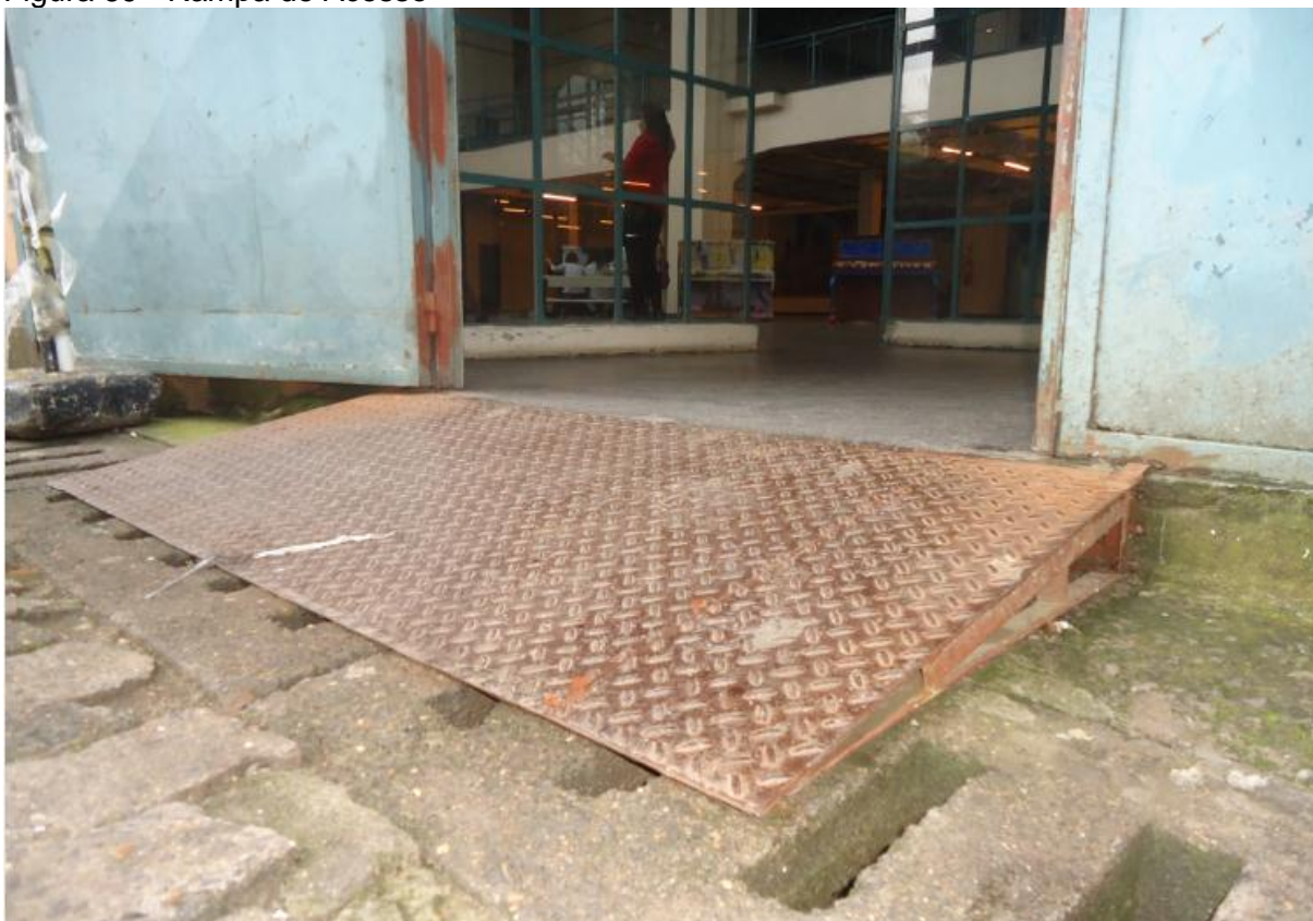
Figura 69 - Rampa de Acesso
