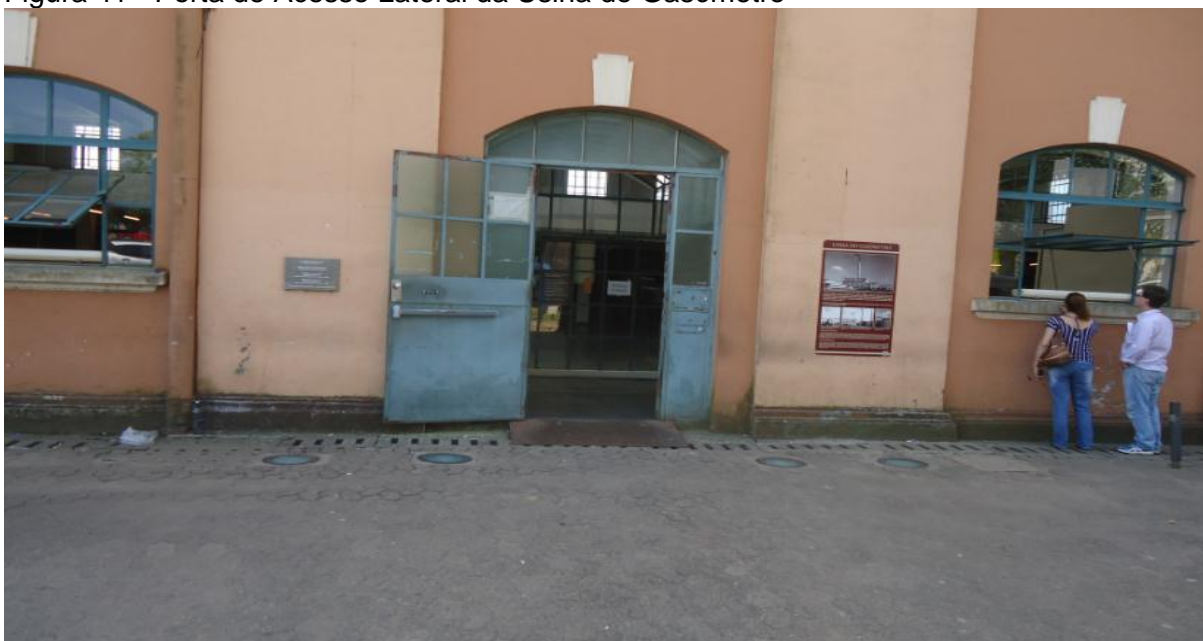
Figura 41 - Porta de Acesso Lateral da Usina do Gasômetro
