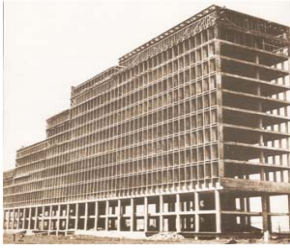
Hospital de Clínicas de Porto Alegre em construção
