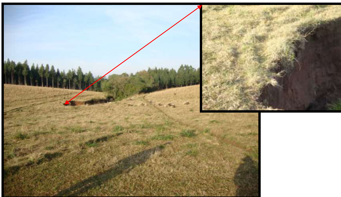
Figura 18: Voçoroca na localidade de Costa do Sutil, Município de Chuvisca. No detalhe, as trilhas feitas pelo pisoteio de animais, que contribuem para o escoamento concentrado para o seu interior. Foto: acervo da autora, 2014.
