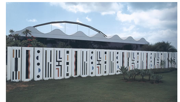
Hospital rede Sarah, arq João Filgueiras Lima Fonte: www.brasiliaonline.com 07/Jun05
