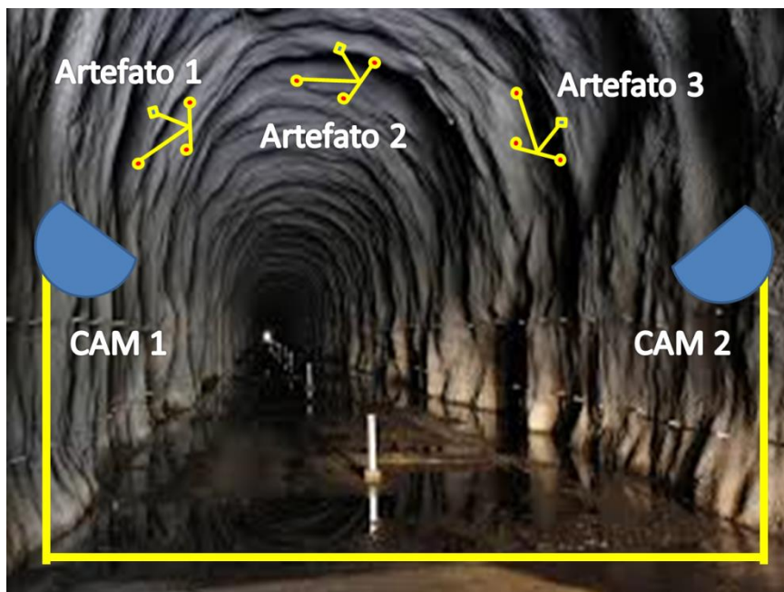
Figura 28 Instalação do Sistema ao Interior do Túnel.
