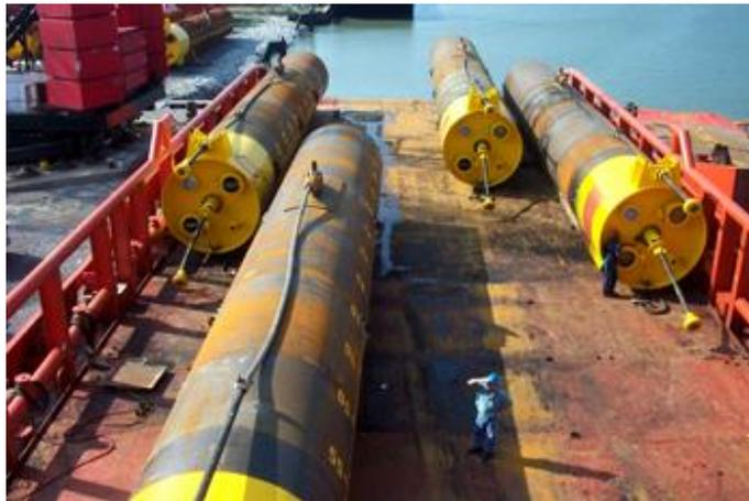
Figura 2.4: Estacas de Sucção (SHARMA, 2004).
