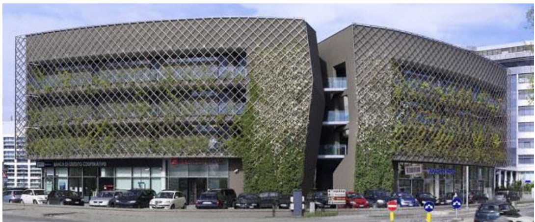
Figura 64: Fachada com grelha de aço e vegetação trepadeira (Fonte: MARIO CUCINELLA ARCHITECTS, 2012)
