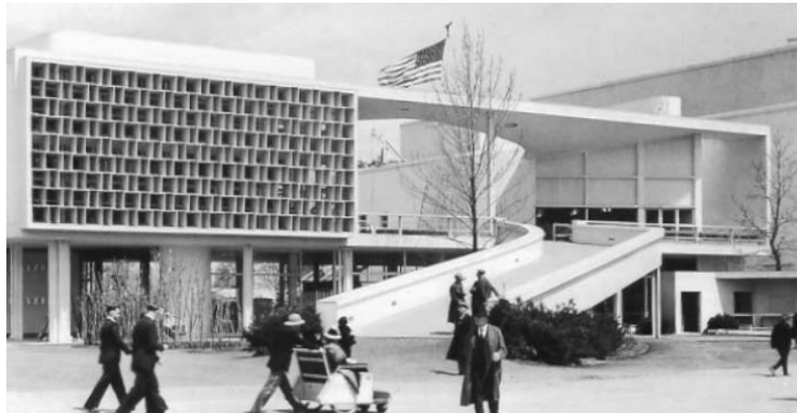
Figura 24: Fachada sul do Pavilhão do Brasil em Nova York, com a colmeia adotada como solução de proteção solar (Fonte: CAVALCANTI, 2001, p.382)
