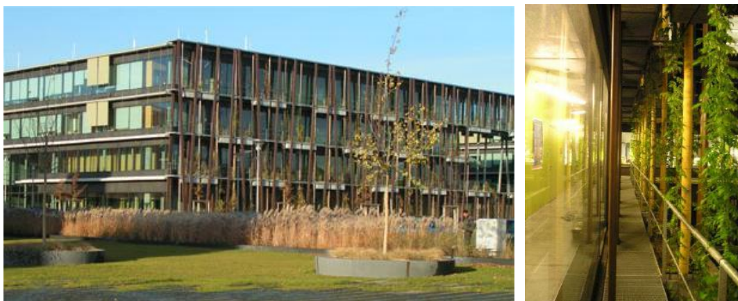
Figura 36: Instituto de Física de Berlim e detalhe das cortinas verdes em frente às áreas envidraçadas (Fonte: INSTITUTE OF PHYSICS IN BERLIN-ADLERSHOF, 2010)
