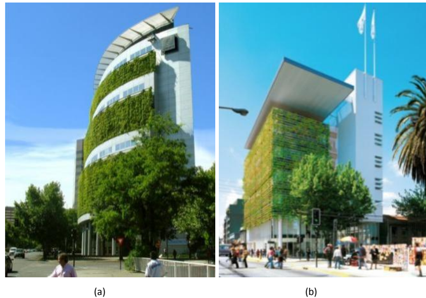
Figura 29: Edificações com as cortinas verdes atuando como elemento de controle solar. a) Edifício Consorcio em Santiago; b) Edifício Consorcio em Concepción (Fonte: ENRIQUE BROWNE Y ASOCIADOS, 2012)
