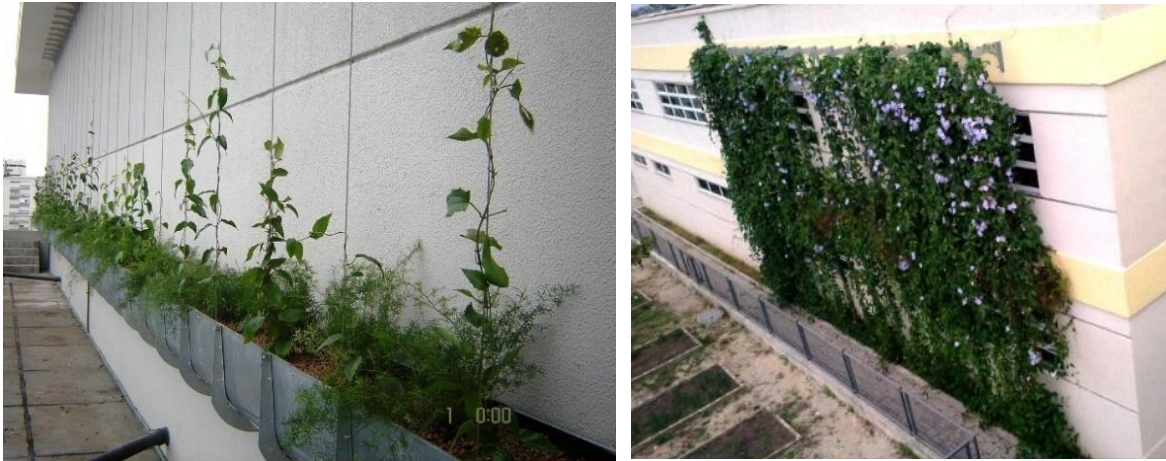
Figura 13: Sistema com cabos da Empresa Ecotelhado (Fonte: ECOTELHADO, 2013)
