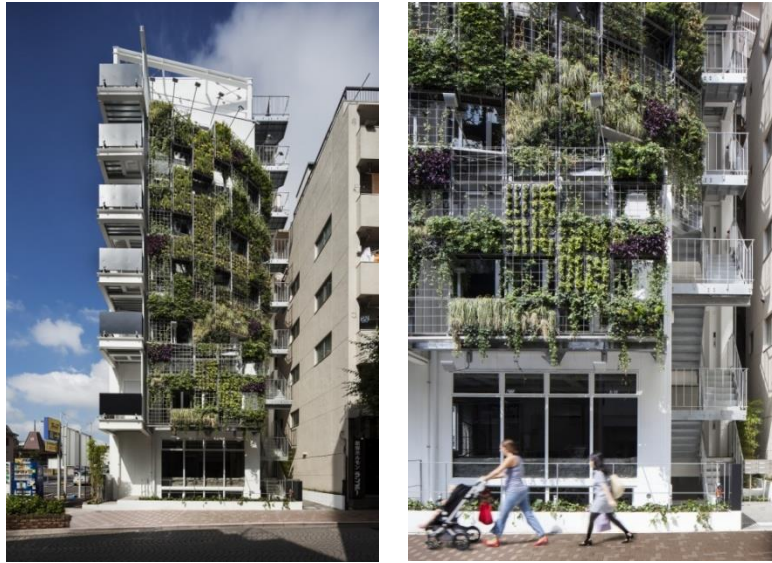
Figura 70: A fachada principal do edifício Vent Vert, com a segunda-pele de vegetação (Fonte: EDWARD SUZUKI, 2013)
