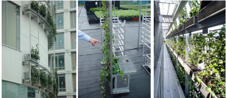
Figura 11: Sistema modular da Empresa GSKy Plant Systems (Fonte: GSKY PLANT SYSTEMS, 2012)
