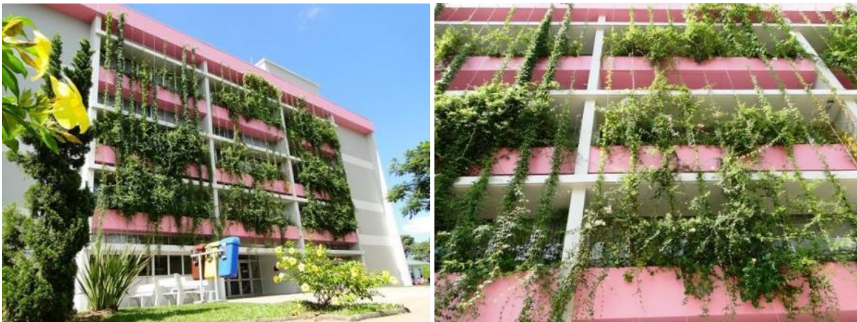
Figura 14: Prédio Rosa da Universidade Feevale, com aplicação do Brise Vegetal da Empresa Ecotelhado (Fonte: ECOTELHADO, 2012)
