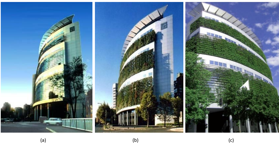
Figura 48: a) O edifício em 1993; b) Em 2007; c) Atualmente (Fonte: ENRIQUE BROWNE Y ASOCIADOS, 2012)
