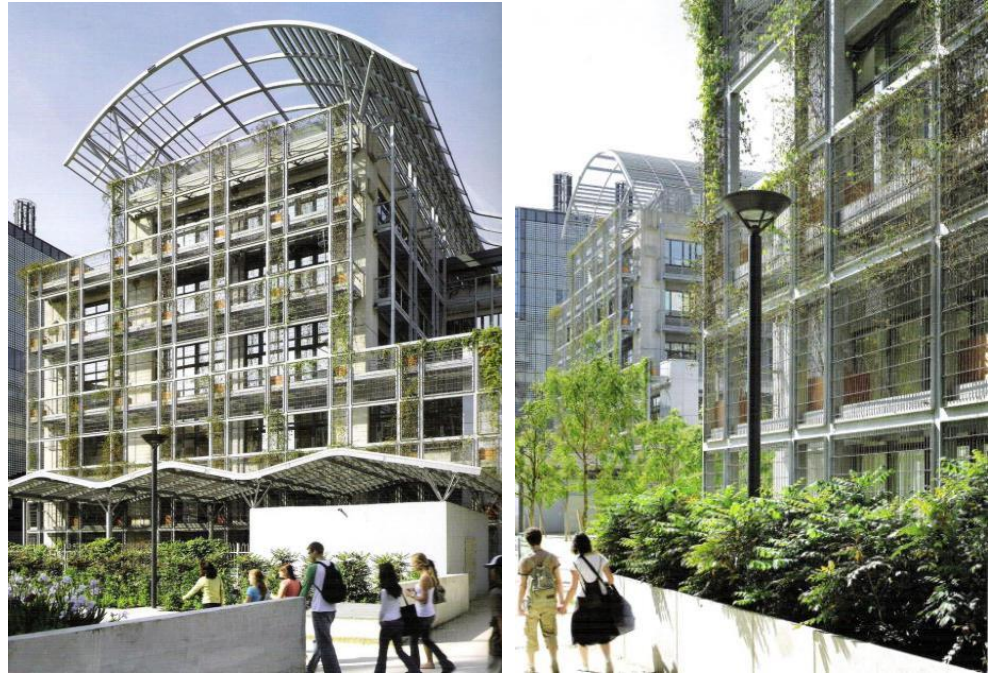
Figura 63: Fachada principal do edifício, com treliças e vegetação trepadeira (Fonte: UFFELEN, 2011, p.108 e 111)
