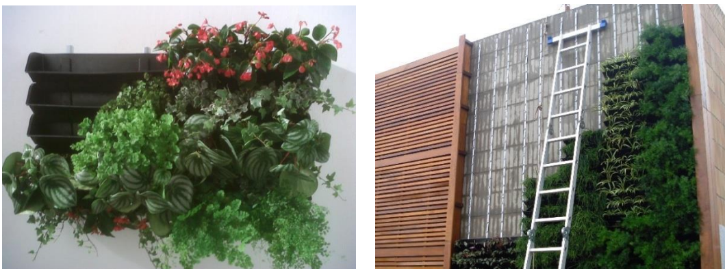
Figura 17: Sistema Canguru, com módulos fixados em estrutura metálica (Fonte: ECOTELHADO, 2013)
