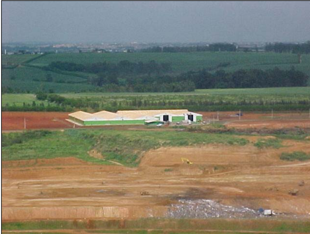
Figura 14 – Vista externa da estação de biorremediação das empresas SAPOTEC LTDA. e ESTRE LTDA., Paulínia – SP, dezembro 2002.
