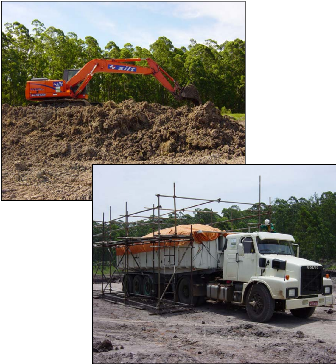
Figura 18 – Escavação e destinação do solo contaminado removido da Mina de Argila/REPLAN, Paulínia – SP, janeiro de 2003.
