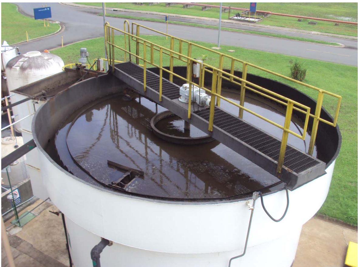
Anexo G: Decantador primário – Indústria do Tabaco.
