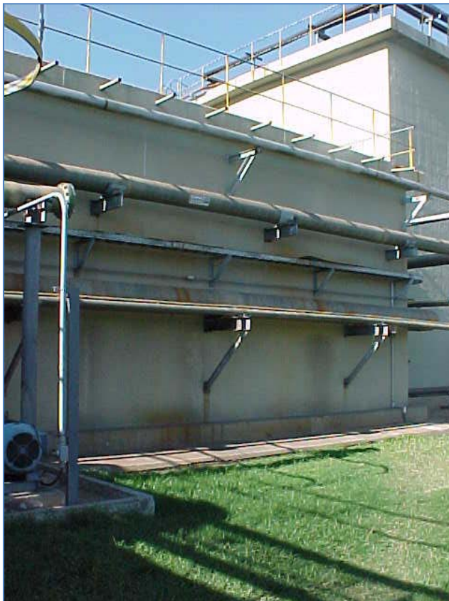
Anexo D: Reator acidogênico – Indústria da Soja.
