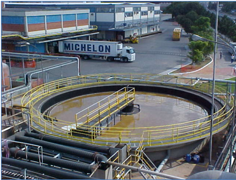
Anexo C: Decantador primário – Indústria da Soja.
