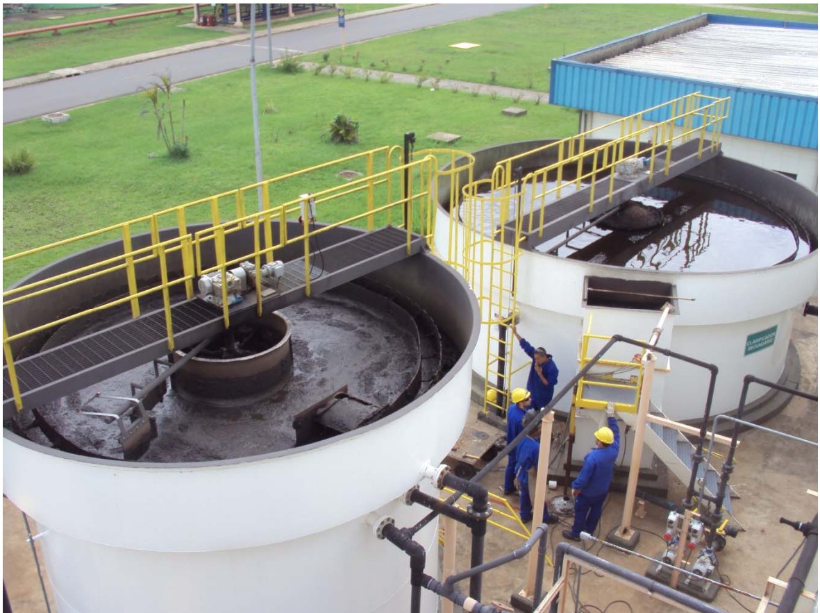
Anexo H: Decantadores secundários – Indústria do Tabaco.
