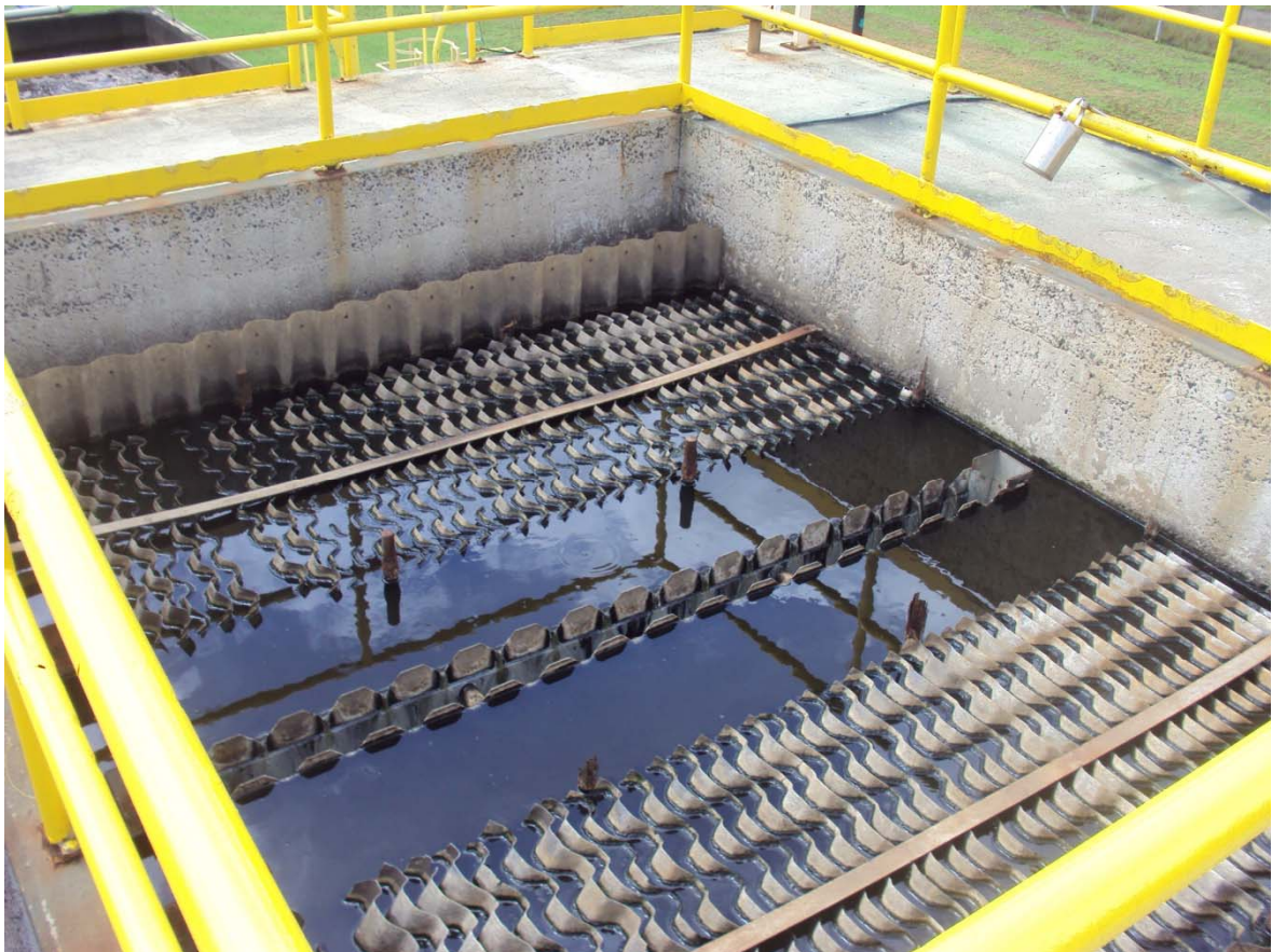
Anexo F: Tanque metanogênico – Indústria do Tabaco.
