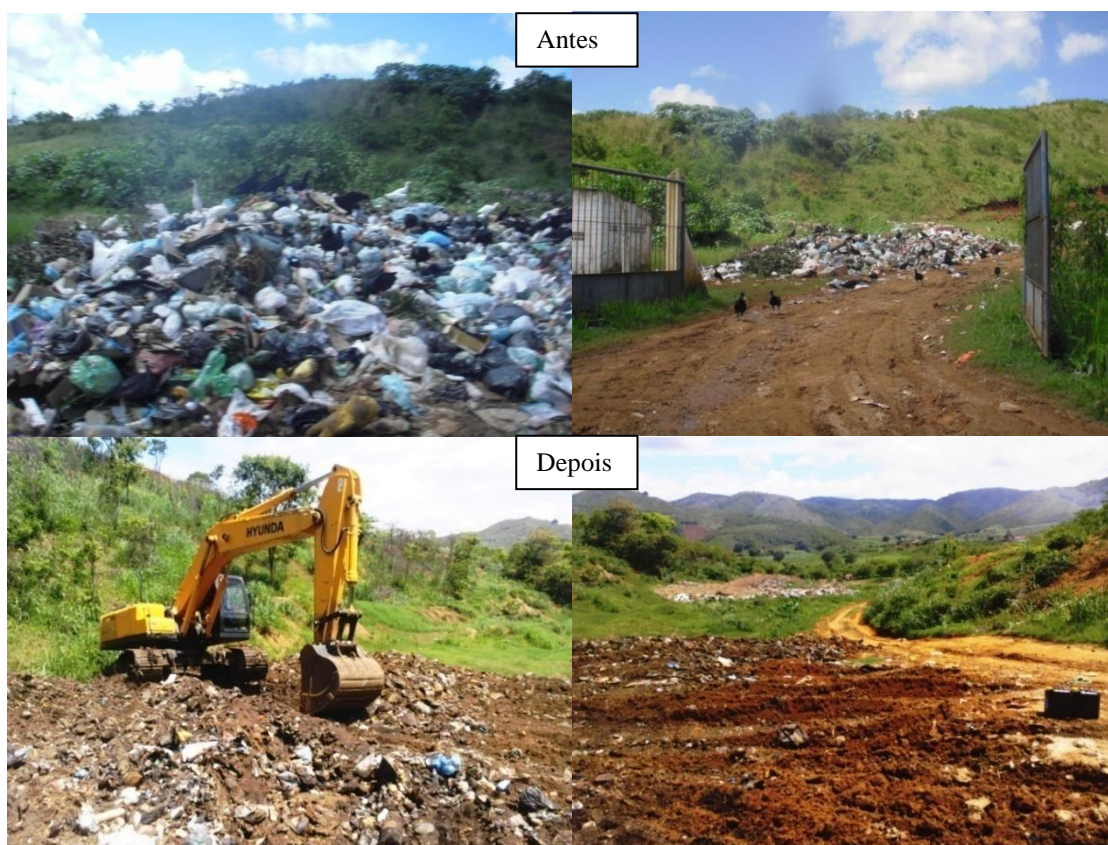
Figura 67: Fotos do antes e depois da Remediação do Aterro Sanitário em 2013
