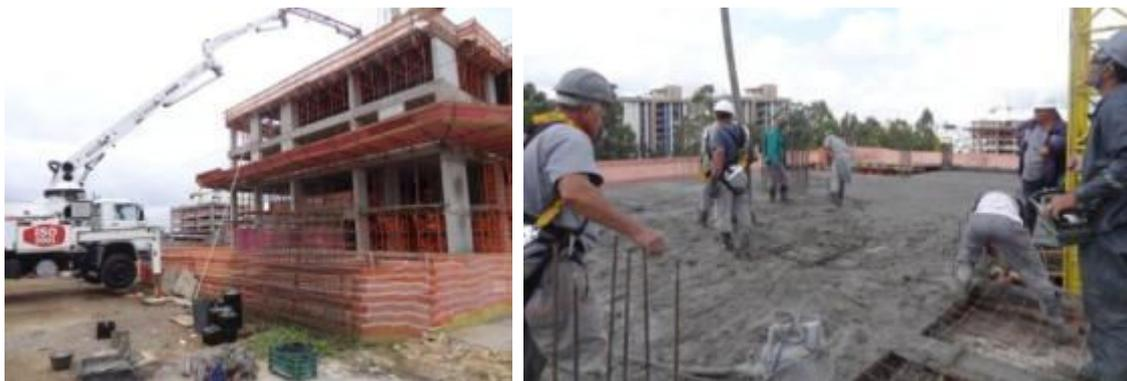
Figura 6.14 - (a) Foto mostrando um panorama geral da obra estudada; (b) Foto mostrando o detalhe do lançamento e adensamento do concreto na laje.
