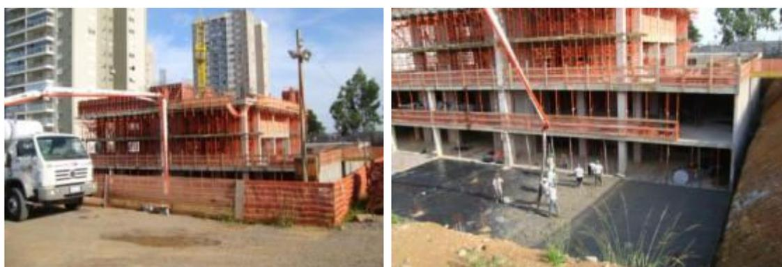
Figura 6.11 - (a) Foto mostrando um panorama geral da obra estudada; (b) Foto mostrando o detalhe do lançamento e adensamento do concreto na laje.
