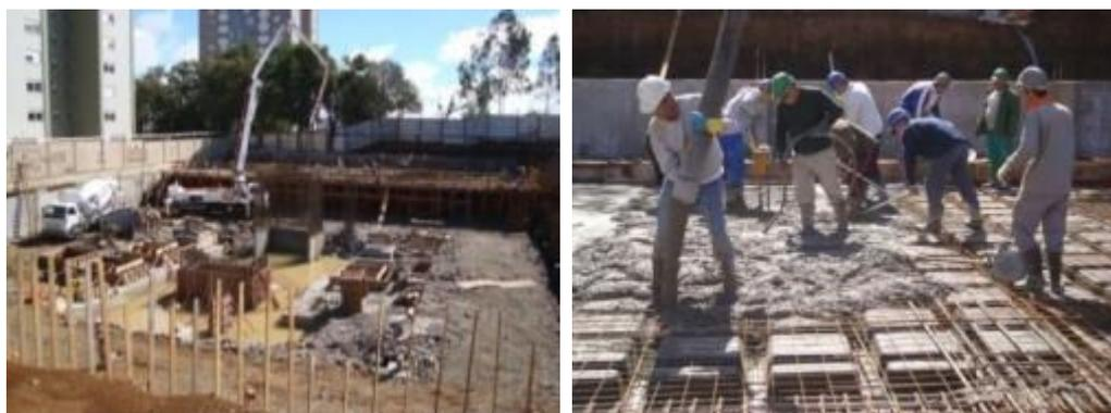
Figura 6.5 - (a) Foto mostrando um panorama geral da obra 1; (b) Foto mostrando o detalhe do lançamento e adensamento do concreto na laje.
