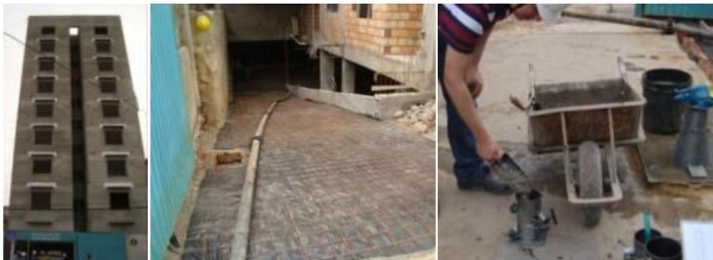
Figura 6.8 - (a) Foto mostrando um panorama geral da obra estudada; (b) Foto mostrando a rampa da garagem que foi concretada e (c) Foto da concretagem dos corpos de prova.
