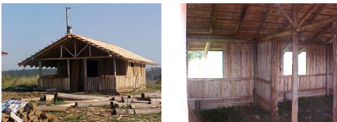
Figura 25: construção Casa do Índio 1 – Tekoa Porã / Barra do Ribeiro – Agosto de 2002 – Fonte: Kátia Ferreira de Oliveira
