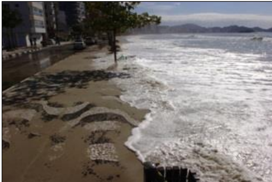
Figura 7. Influência de eventos de maré meteorológica na Praia Central de Balneário Camboriú, com o mar avançando sobre o calçadão e avenida beira mar (Foto: Marcos Porto).
