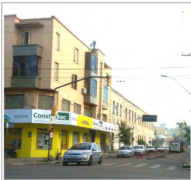
Figura 36 - Avenida Pernambuco, Bairro São Geraldo/Massas Adria. Fonte: Foto da autora.
