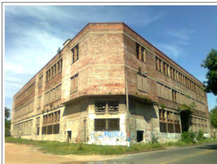
Figura 44: Edifício desocupado de La Aurora. Fonte: Foto da autora.
