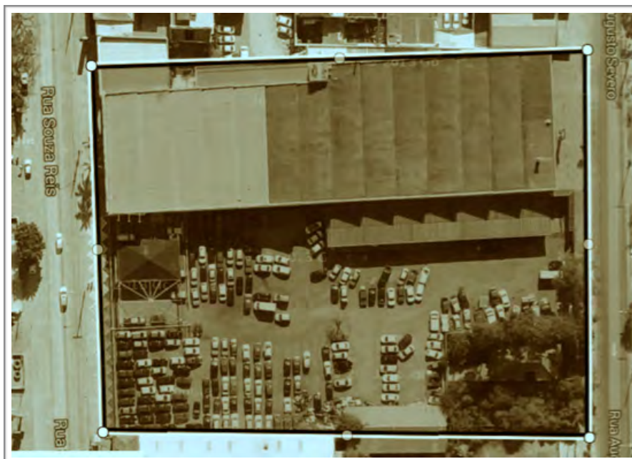
Figura 16 - Antiga localização Aços Laminados Panatlântica S.A. Fonte: Google Maps, 2014. Elaborado pela autora.
