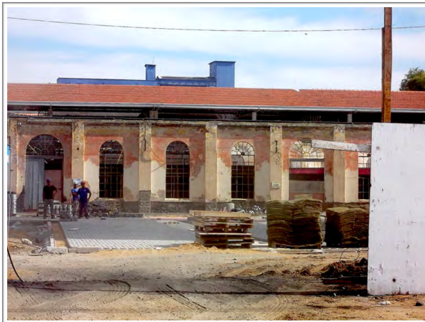
Figura 57: Obras do Projeto ROSSI/FIATECI Fonte: Foto da autora
