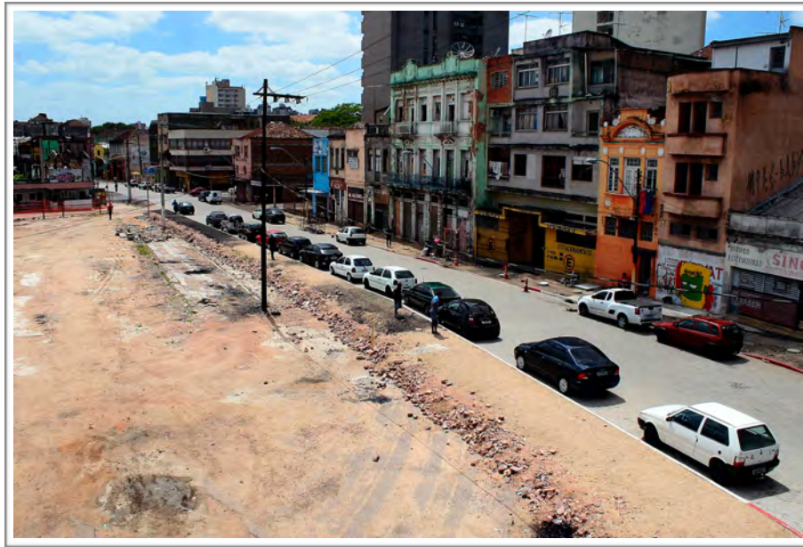
Figura 34 - Detalhe das obras na Rua Voluntários da Pátria Fonte: disponível em < www.transparencianacopa.com.br > Acesso em 15/02/2014.
