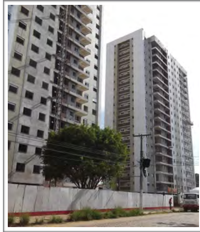
Figura 54: Edifícios em construção - Projeto ROSSI/FIATECI Fonte: Foto da autora.
