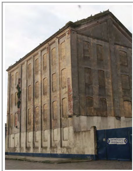
Figura 10 - Antigo Moinho Rio-Grandense S. A., Rio Grande/RS - utilizado como “Entrepósito Frigorífico Pescal” Fonte: Foto de Laís V. Ramalho cedida para esta pesquisa - Modificada pela autora.
