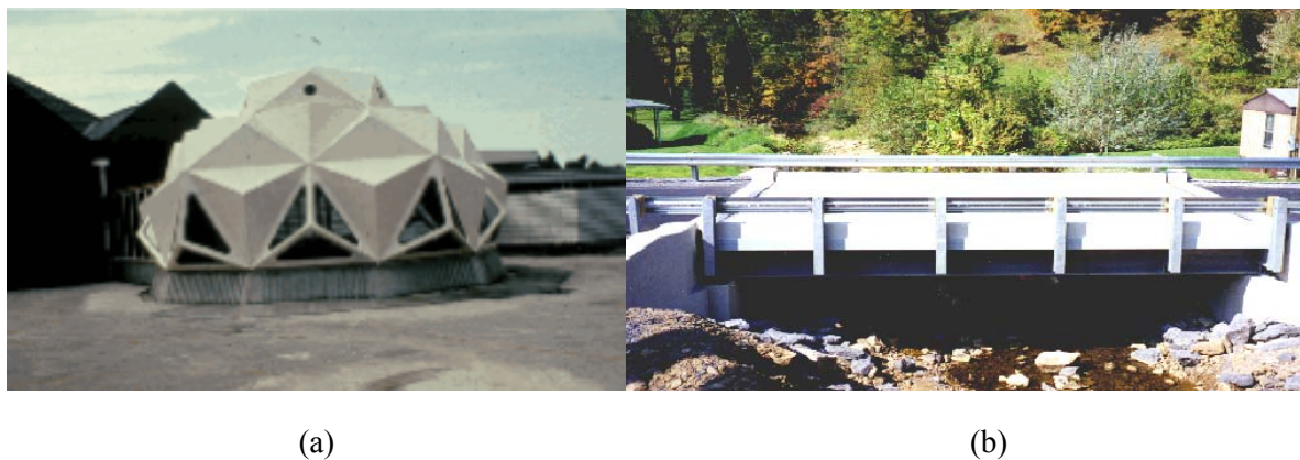
Figura 1.3 – Aplicação de PRF: (a) Sala de aula construída com compósitos de fibra de vidro e resina poliéster, UK; (b) Tabuleiro em PRFV da ponte Wickwire, WV, USA. [Hollaway e Hackman, 2004].
