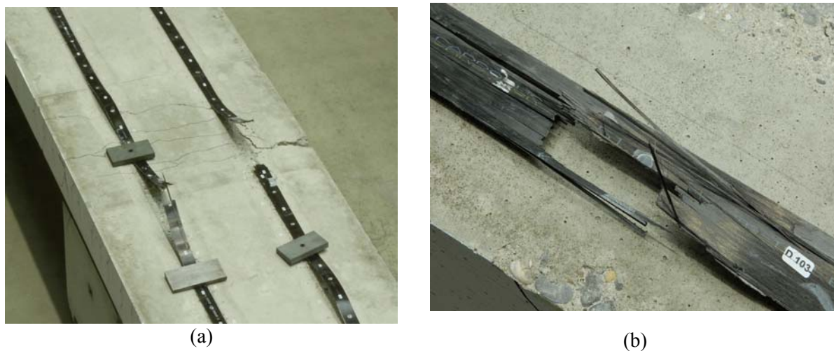
Figura 6.8 – Detalhes da ruptura do reforço: (a) Laminados rompidos próximo à fissura de flexão; (b) Detalhe da ruptura do laminado mais afastado da fissura.
