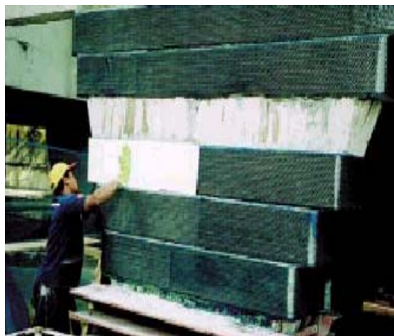
Figura 2.4 – Aplicação de PRFC em pilares de concreto armado com emprego da técnica de moldagem por contato [Monge, 2004].
