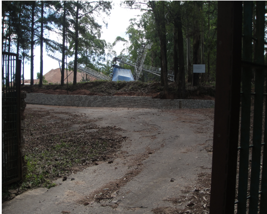
Figura 7: A entrada da usina
