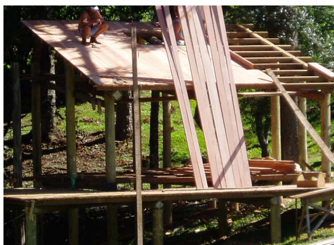
Figura 61: madeiramento da estrutura do telhado (MENZ, 2004)
