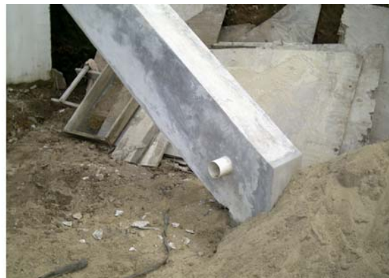
Figura 88: filtro de tela na boca do tubo de escoamento de Ø 100mm (MENZ, 2004)
