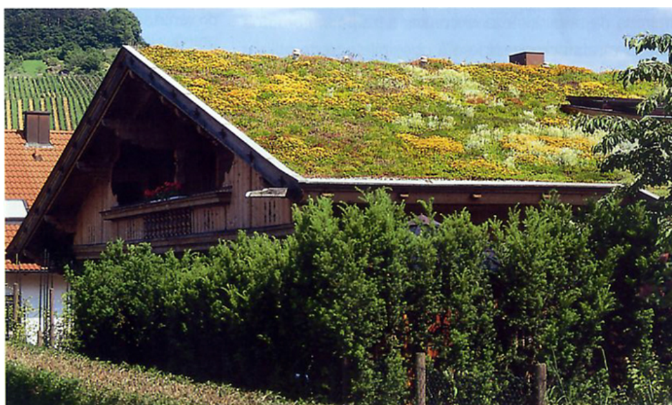
Figura 7: cobertura viva extensiva (ZINCO, 1998)
