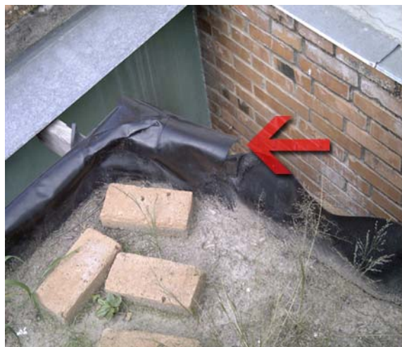
Figura 48: recortes da manta nas bordas
