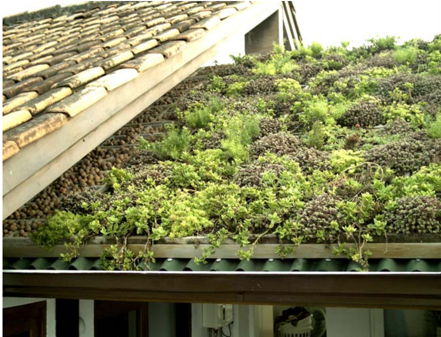
Figura 52: “Ecotelhado”, cinco meses após sua montagem
