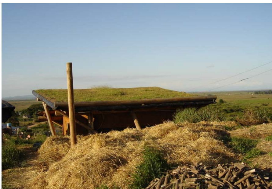
Figura 137: cobertura finalizada, em março de 2004
