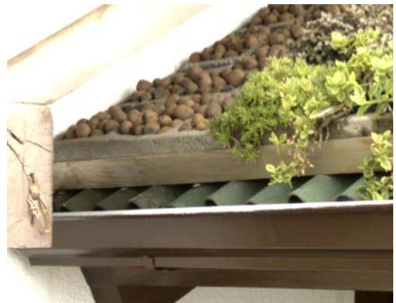
Figura 54: bandejas preenchidas com pedras próximo à parede
