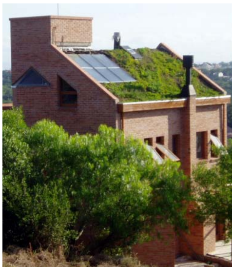
Figura 95: cobertura viva inclinada com coletor solar (MENZ, 2004)
