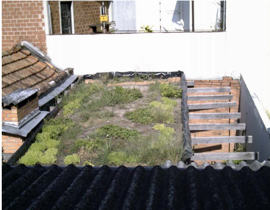
figura 45: cobertura viva sob suporte aparente
