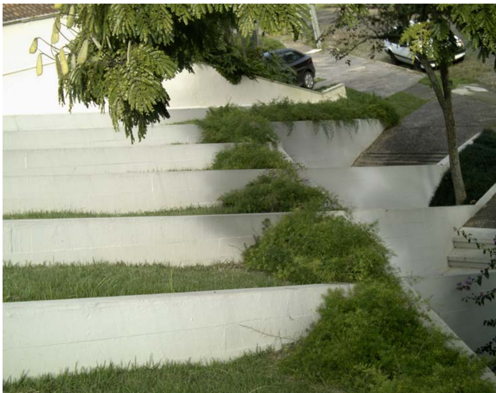
Figura 32: grama sobre as lajes entre vigas
