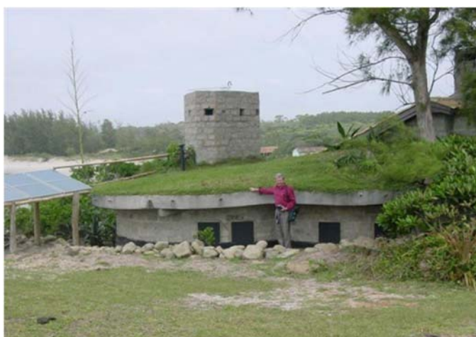
Figura 21: Residência na Praia do Ouvidor (foto de Vanda Elizabet Zanella)
