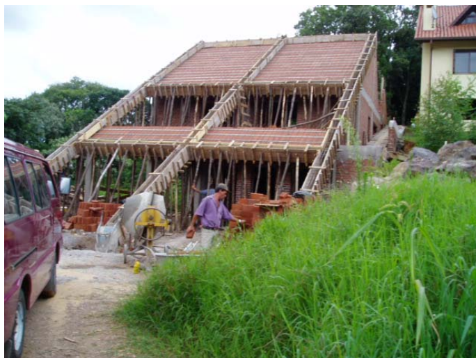
Figura 81: estruturação do telhado
