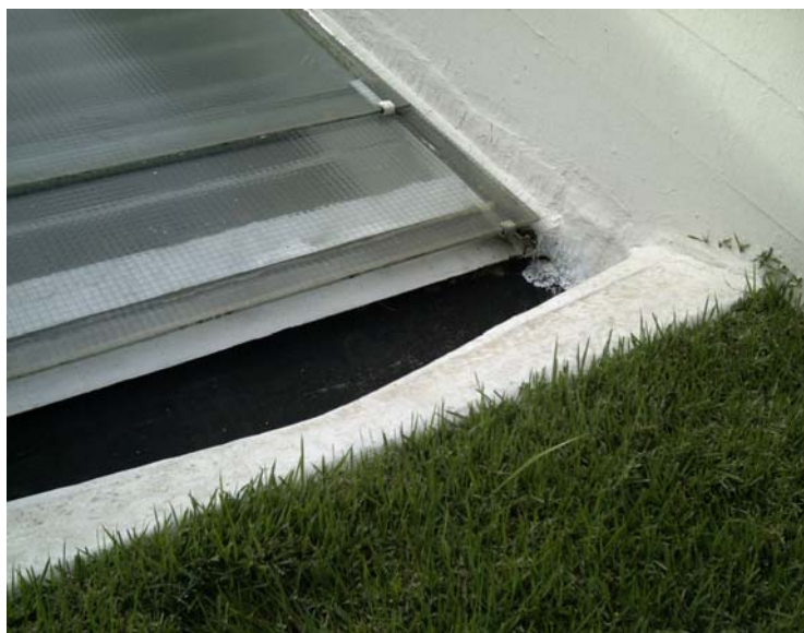
Figura 34: calha anterior à cobertura viva
