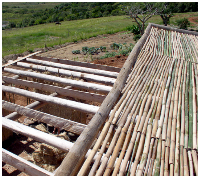
Figura 130: estrutura da cobertura viva 17
