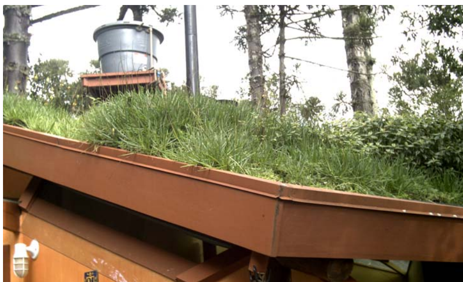
Figura 78: vegetação na cobertura em junho de 2005
