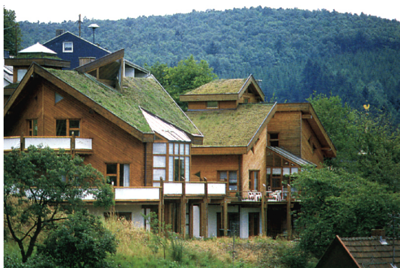
Figura 30: coberturas de grama com 45° de inclinação em Siegen-Oberscheiden, Alemanha (MINKE, 2004)
