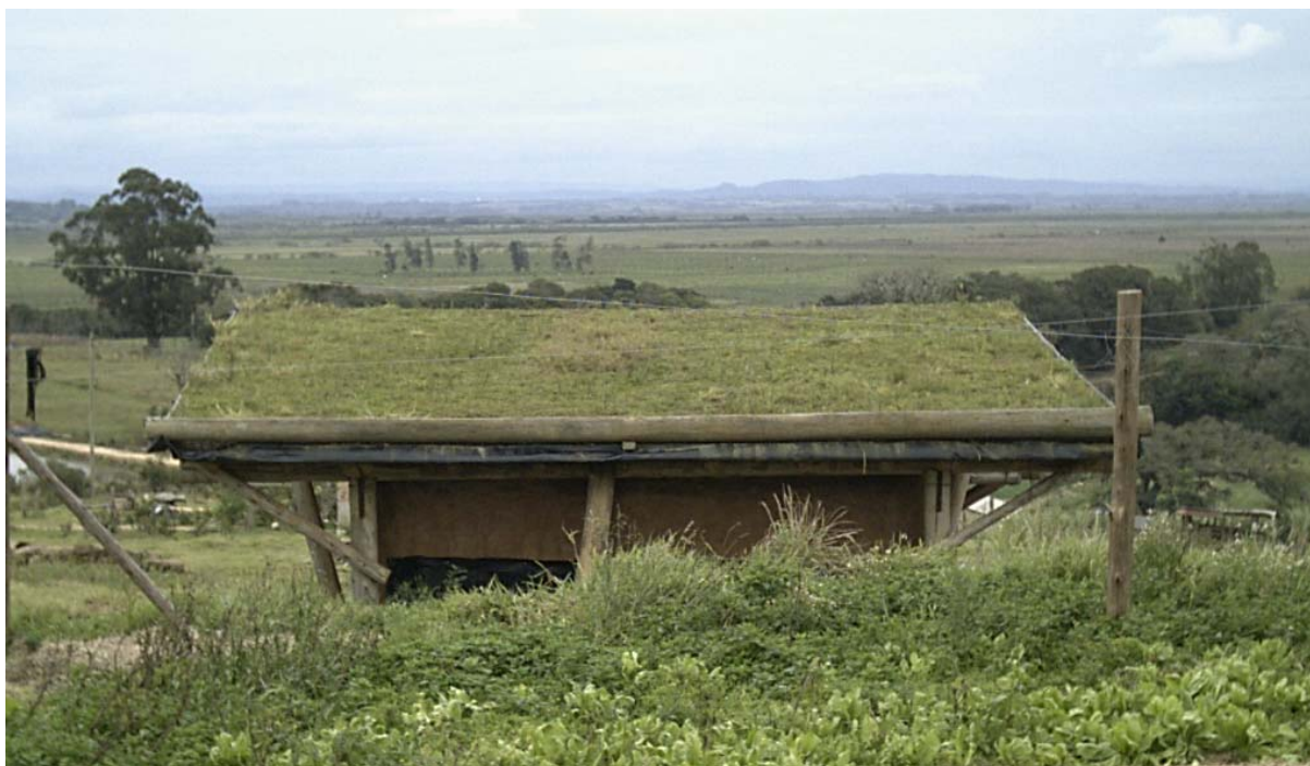
Figura 129: cobertura do Centro de Convívio em setembro de 2005
