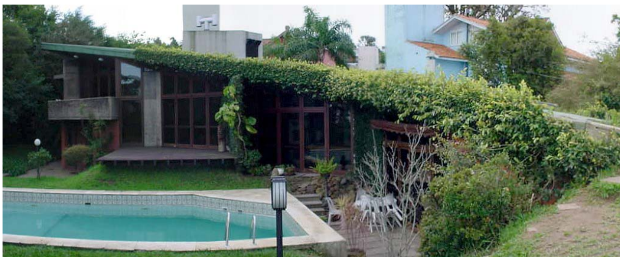
Figura 116: cobertura fotografada em 2005, já sem a cobertura de grama
