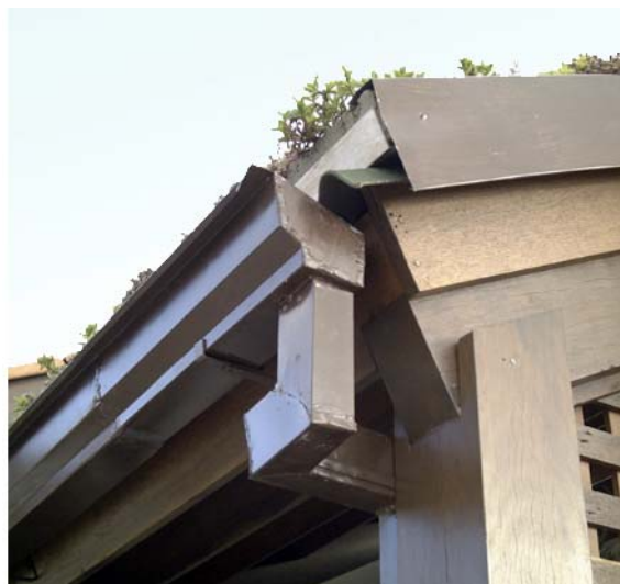
Figura 57: calha e pluvial
