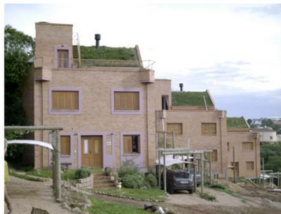
Figura 107: vista das coberturas inclinadas
