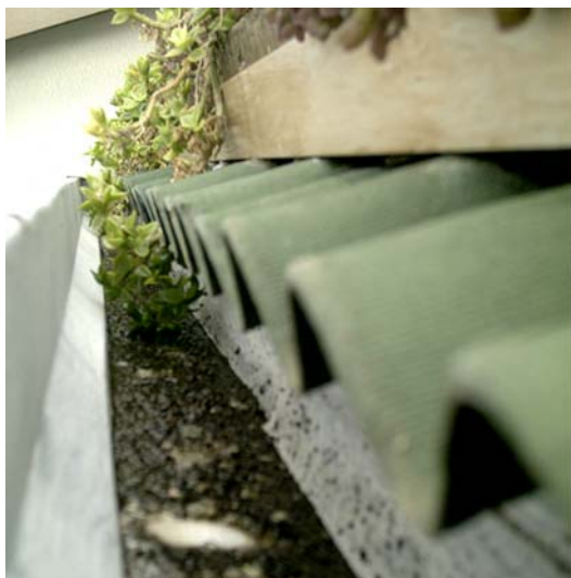
Figura 56: calha impermeabilizada
