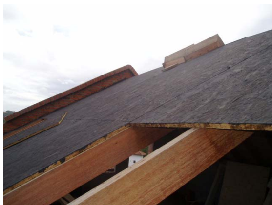
Figuras 97 e 98: chapas de OSB sobre caibros (MENZ, 2004)
