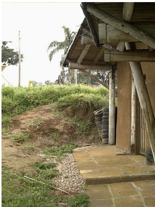
Figura 136: camada de brita para receber as águas residuais da cobertura
