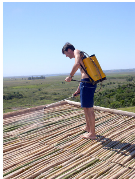
Figura 131: ácido bórico sendo borrifado no bambú 18
