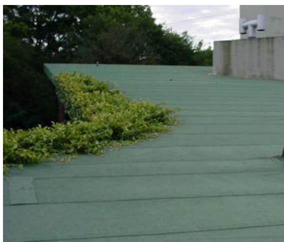
Figura 121: hera se espalhando pela manta
