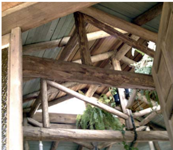
Figura 40: tesouras de ripas de eucalipto
