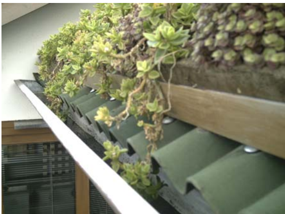
Figura 53: bandeja metálica segurando o conjunto
