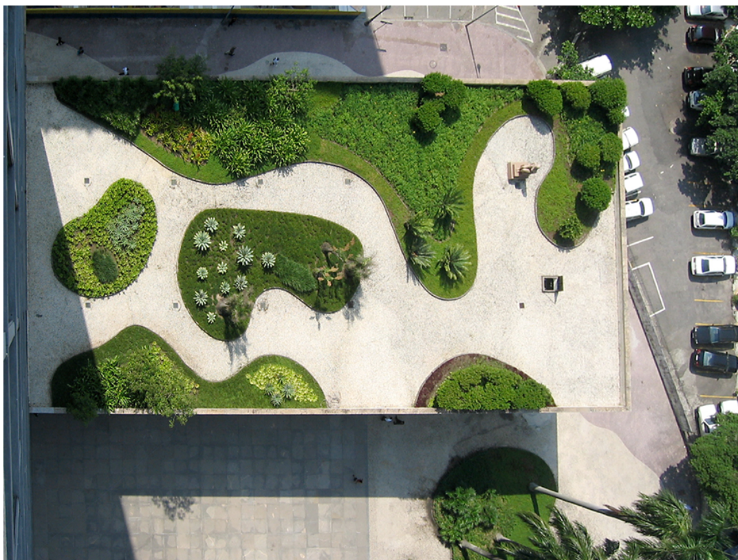
Figura 5: terraço-jardim do edifício do MEC 2
