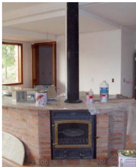
Figura 96: forno/lareira no sótão, abaixo da cobertura (MENZ, 2004)
