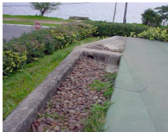
Figura 120: camada de brita na calha
