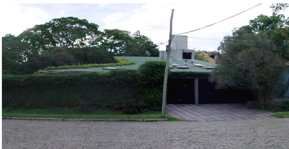
Figura 118: cobertura fotografada em 2005, com a manta ardosiada
