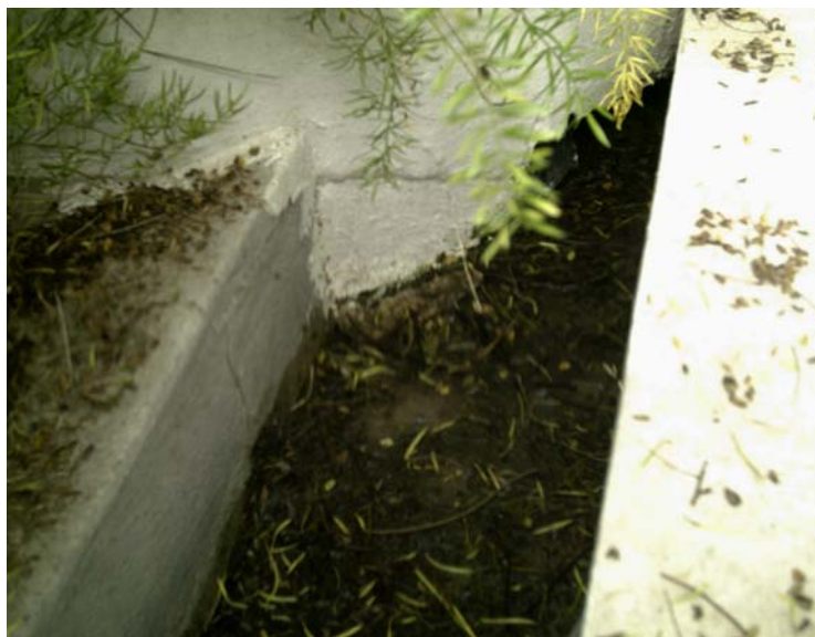
Figura 33: calha de concreto impermeabilizada
