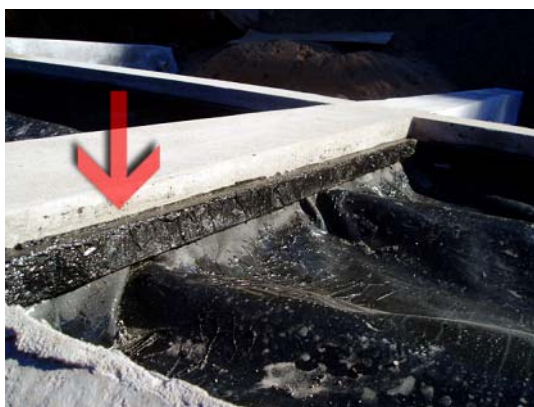
Figura 85: sarrafo prendendo o PEAD. Baseado em (MENZ, 2004)
