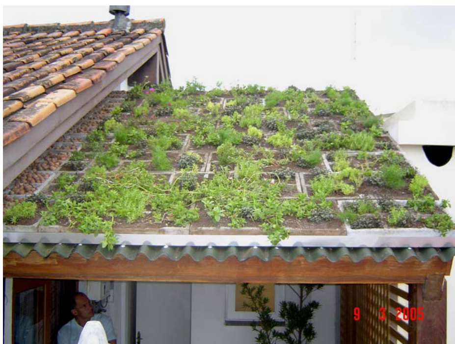
Figura 51: “Ecotelhado”, alguns dias após sua montagem no local 10
