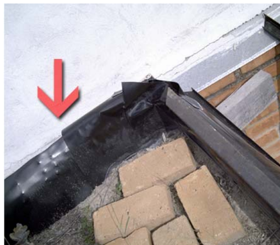
Figura 49: sobreposição da manta
