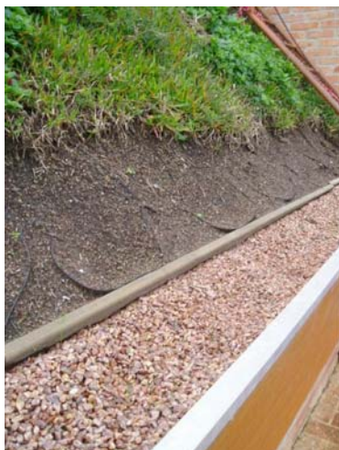
Figura 102: geo-membrana sob a terra
