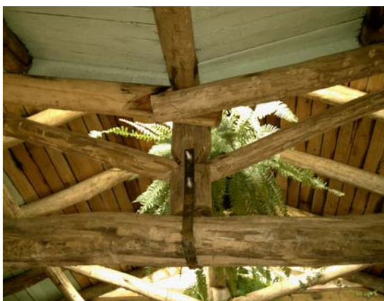
Figura 39: amarras com cinta de ferro e parafusos
