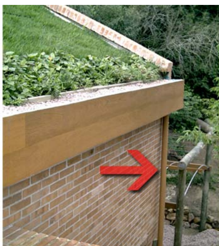
Figura 104: detalhe da canalização pluvial externa
