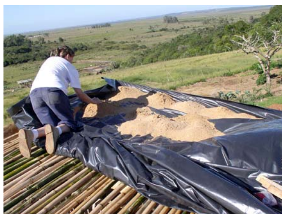
Figura 132: colocação da lona e da camada de areia 19
