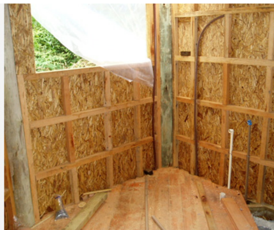
Figura 63: detalhe das paredes em aglomerado OSB (MENZ, 2004)
