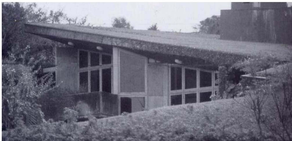
Figura 117: a cobertura, ainda com grama, excessivamente cortada (MINKE, 2004)
