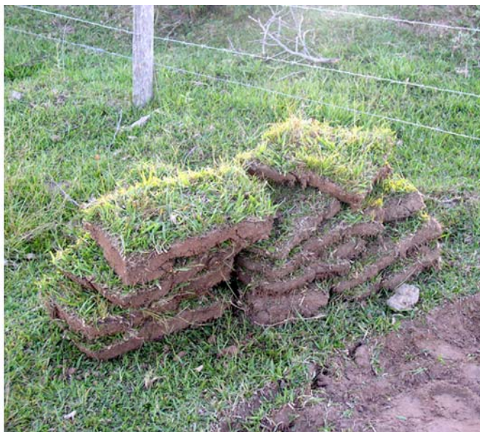
Figura 135: leivas de grama prontas para serem colocadas na cobertura
