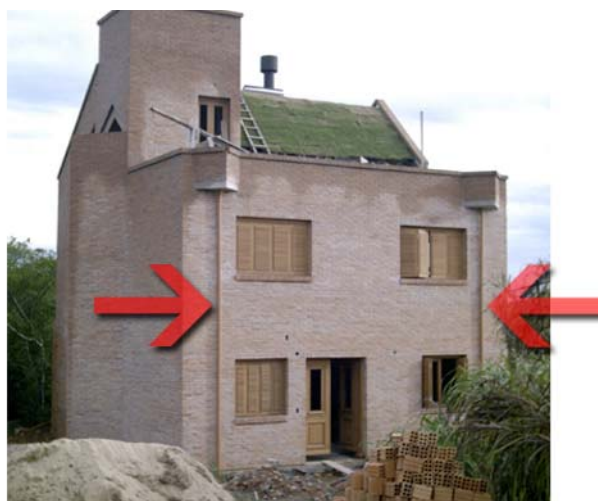
Figura 105: descida do pluvial pela fachada
