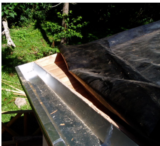
Figura 70: calha metálica (MENZ, 2004)
