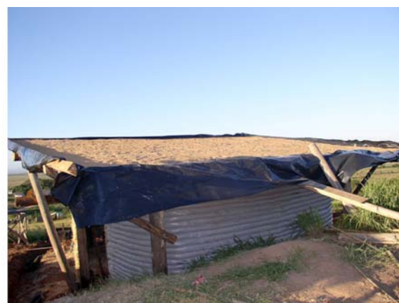
Figura 133: camada de areia pronta para receber manta de PEAD 20
