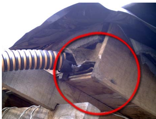
Figura 47: saída do dreno
