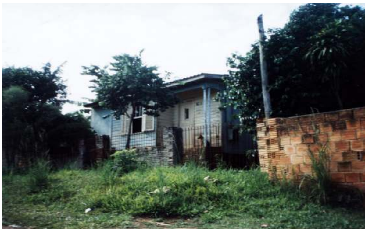
Figura 84. Casa de madeira, em regular estado de conservação
