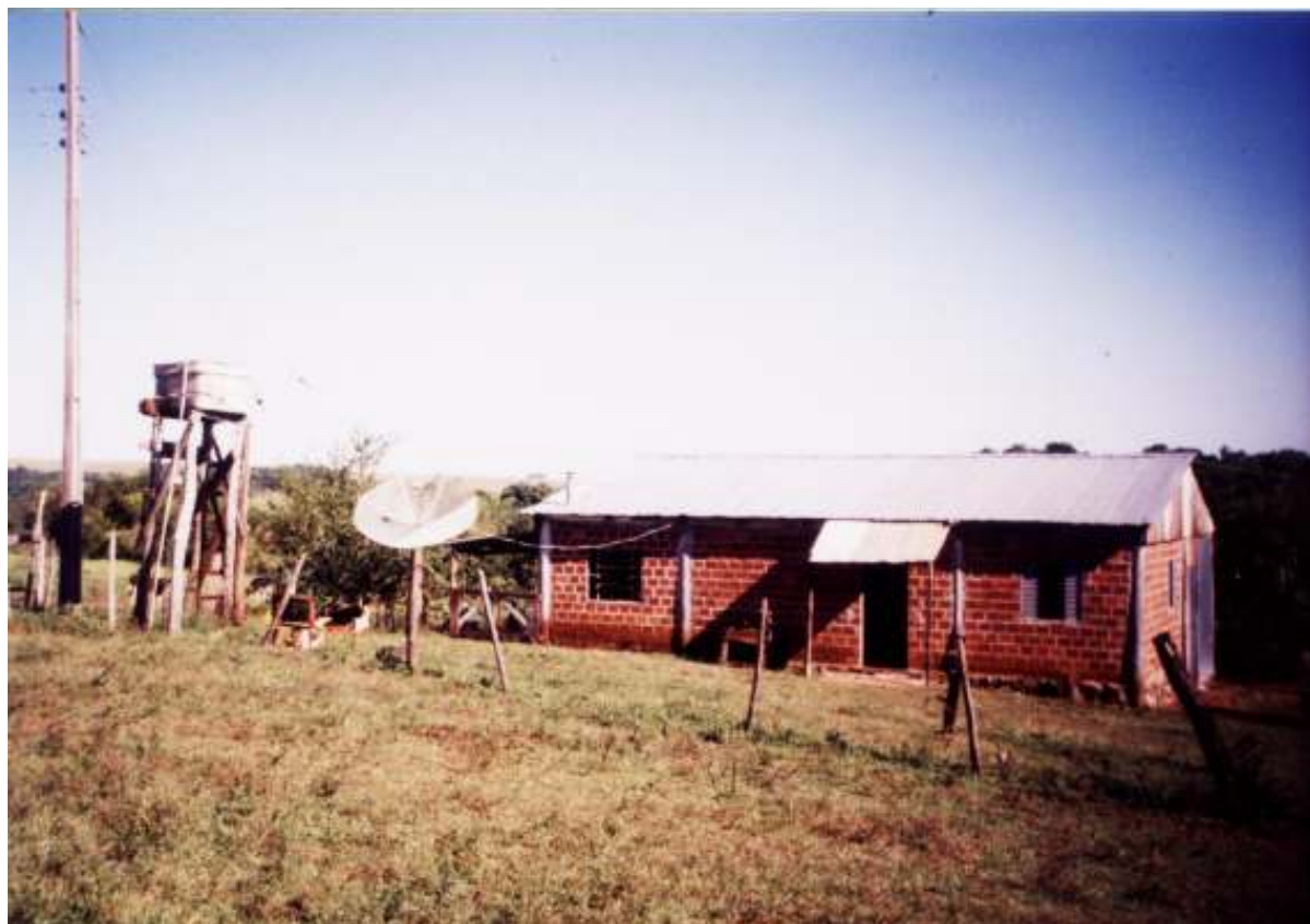
Figura 71. Casa de tijolos furados aparentes, em razoável estado de conservação, sendo que o galpão para depósito de sementes, insumos e maquinários é junto à moradia
