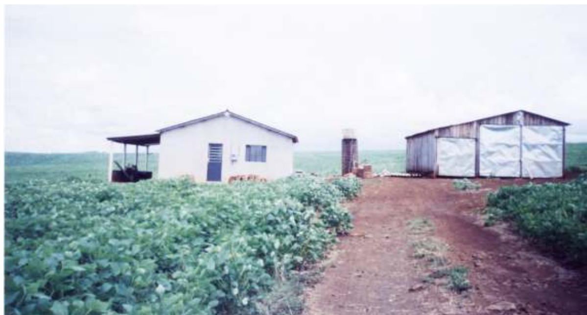
Figura 72. Casa de tijolos furados, revestida com argamassa e galpão independente em anexo
