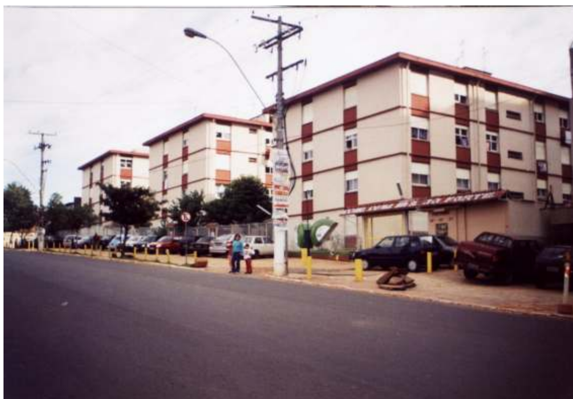
Figura 89. Edificação de habitações multifamiliares, em ótimo estado de conservação
