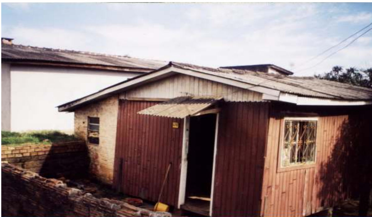
Figura 82. Casa mista (madeira e alvenaria de tijolos furados), com condições precárias de habitabilidade
