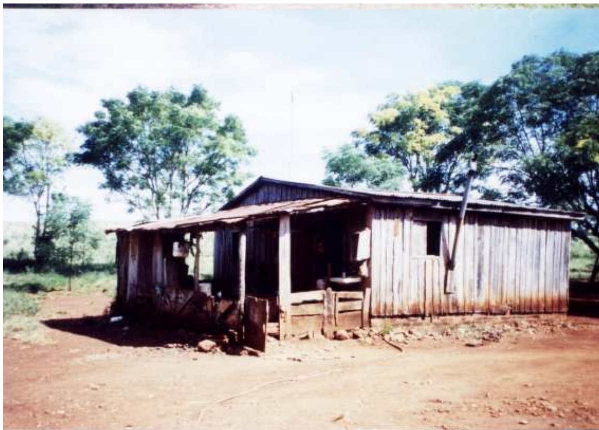
Figura 67. Casa de madeira, em péssimo estado de conservação
