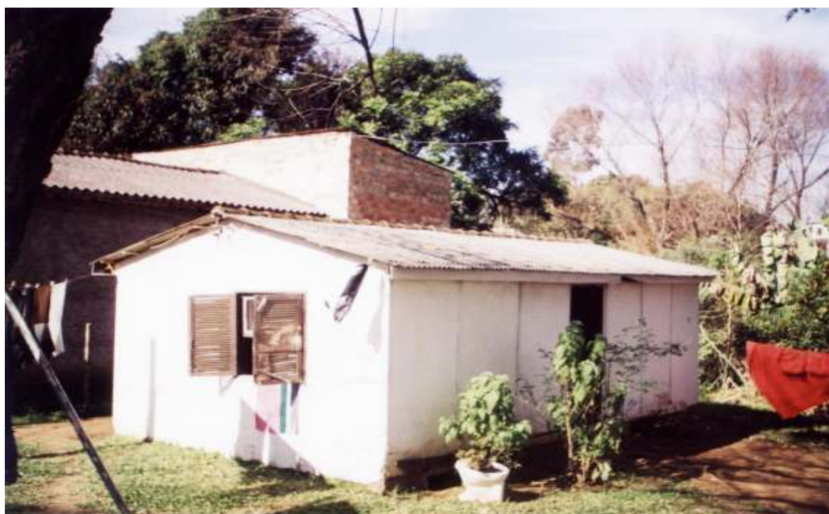
Figura 85. Casa de paredes e cobertura de cimento amianto em razoável estado de conservação
