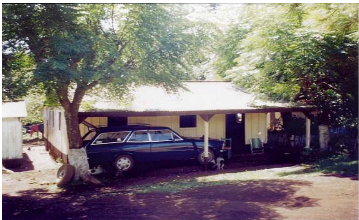
Figura 80. Casa de madeira, em bom estado de conservação
