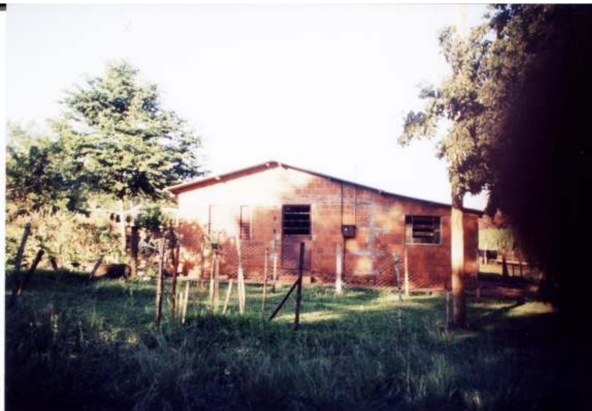
Figura 77. Casa de alvenaria de tijolos furados aparentes, em razoável estado de conservação
