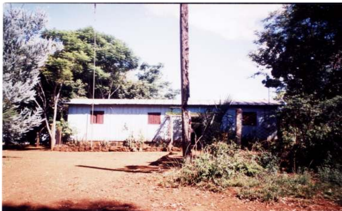
Figura 68. Casa de madeira, em regular estado de conservação
