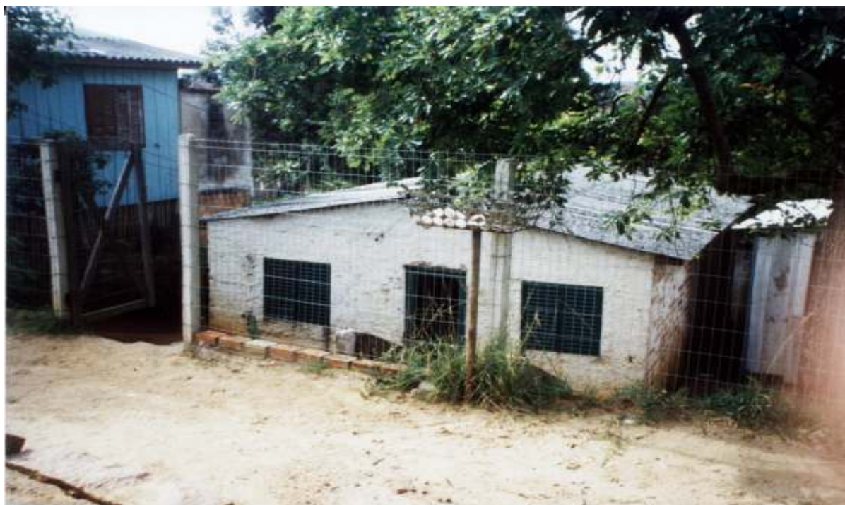
Figura 88. Casa de alvenaria de tijolos furados, com pintura, em razoável estado de conservação
