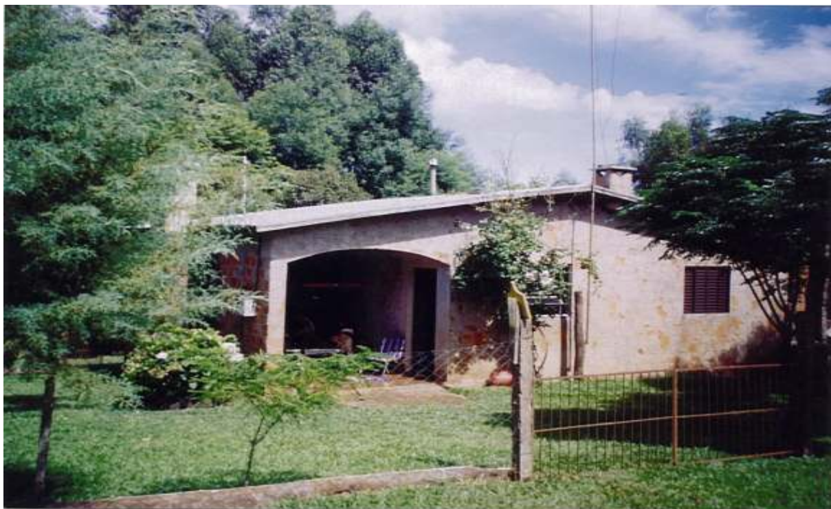
Figura 79. Casa de alvenaria de tijolos furados, com emboço, em razoável estado de conservação
