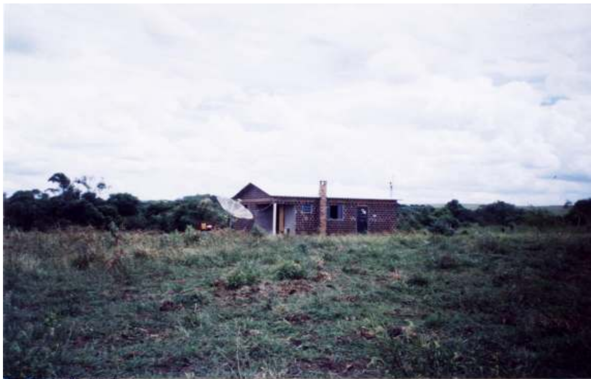
Figura 76. Casa de alvenaria de tijolos furados aparentes, em bom estado de conservação
