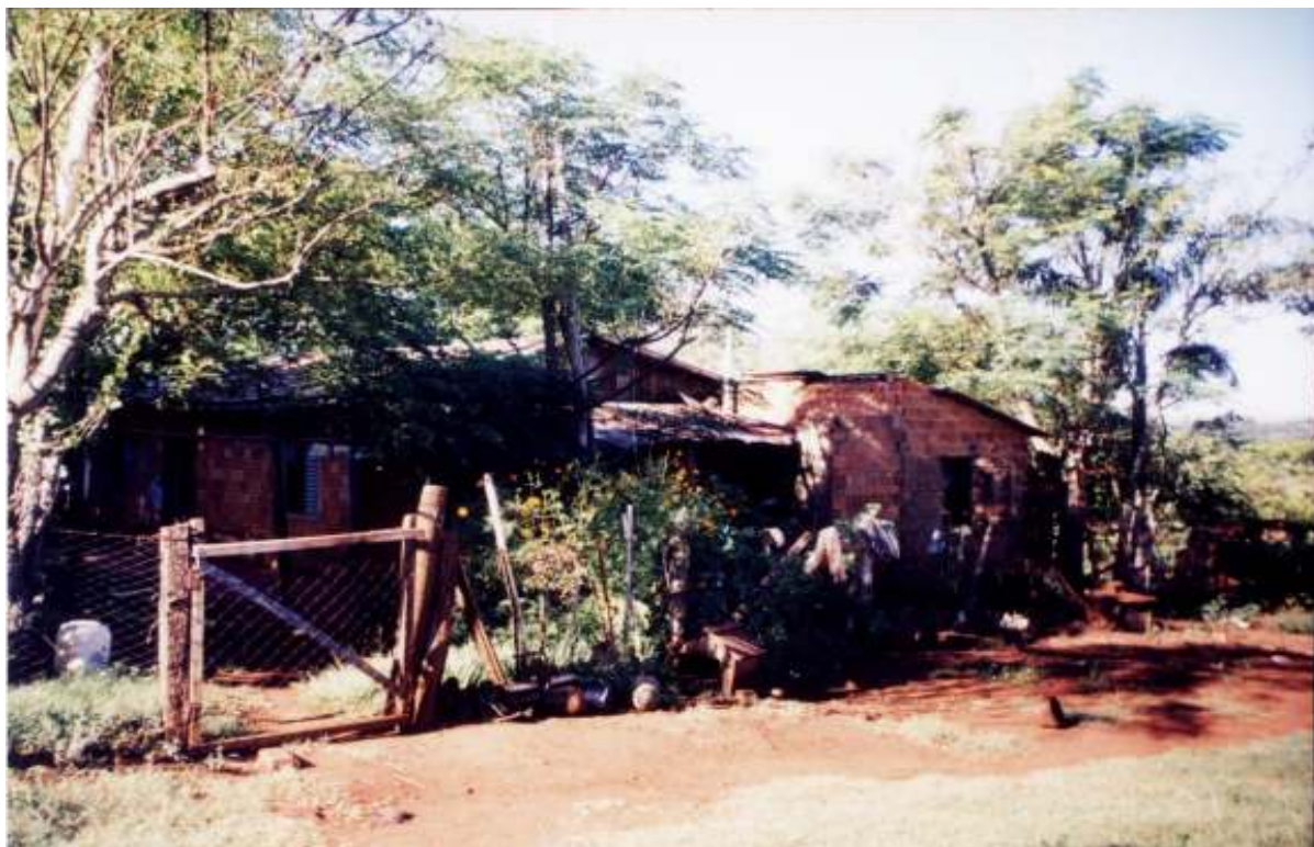
Figura 73. Casa de tijolos furados aparentes, próxima a um galpão de pequenas dimensões em regular estado de conservação
