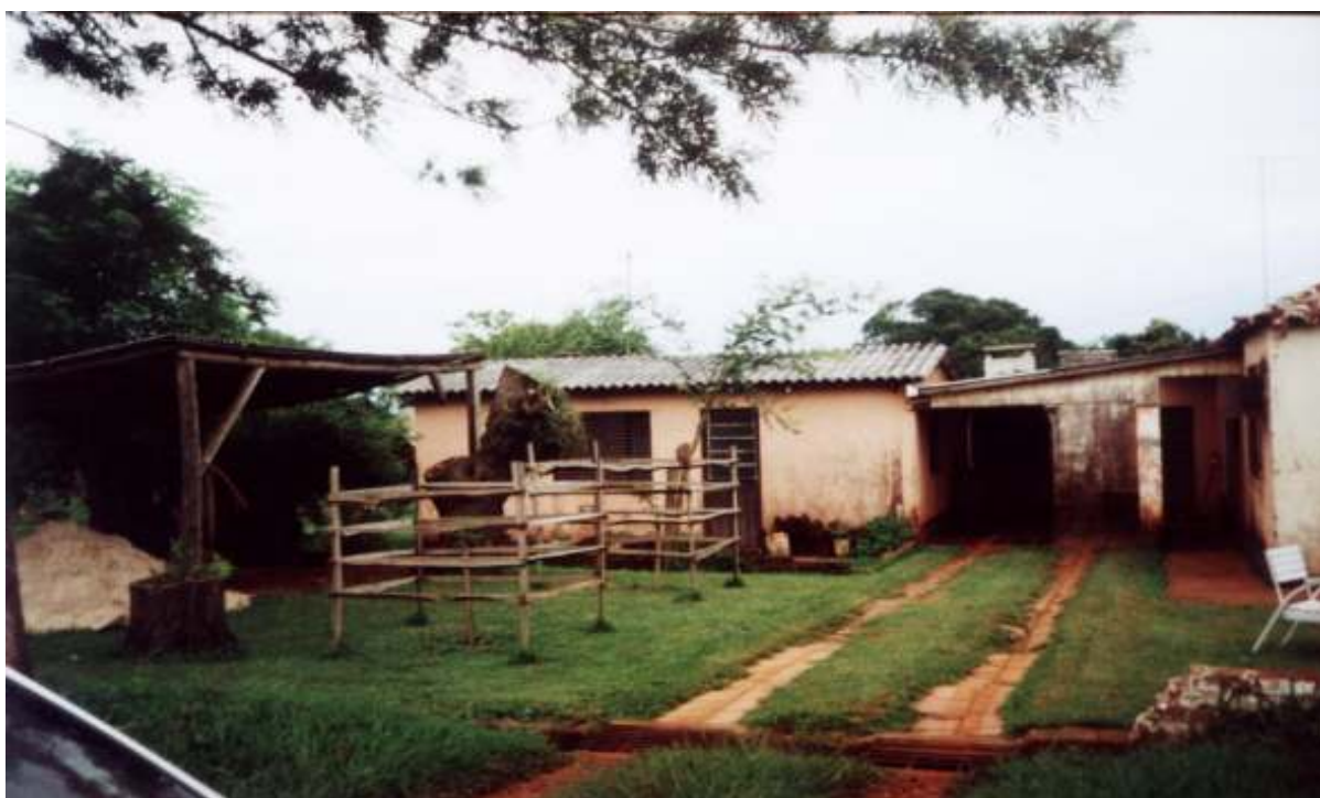
Figura 74. Casa de alvenaria revestida, em regular estado de conservação
