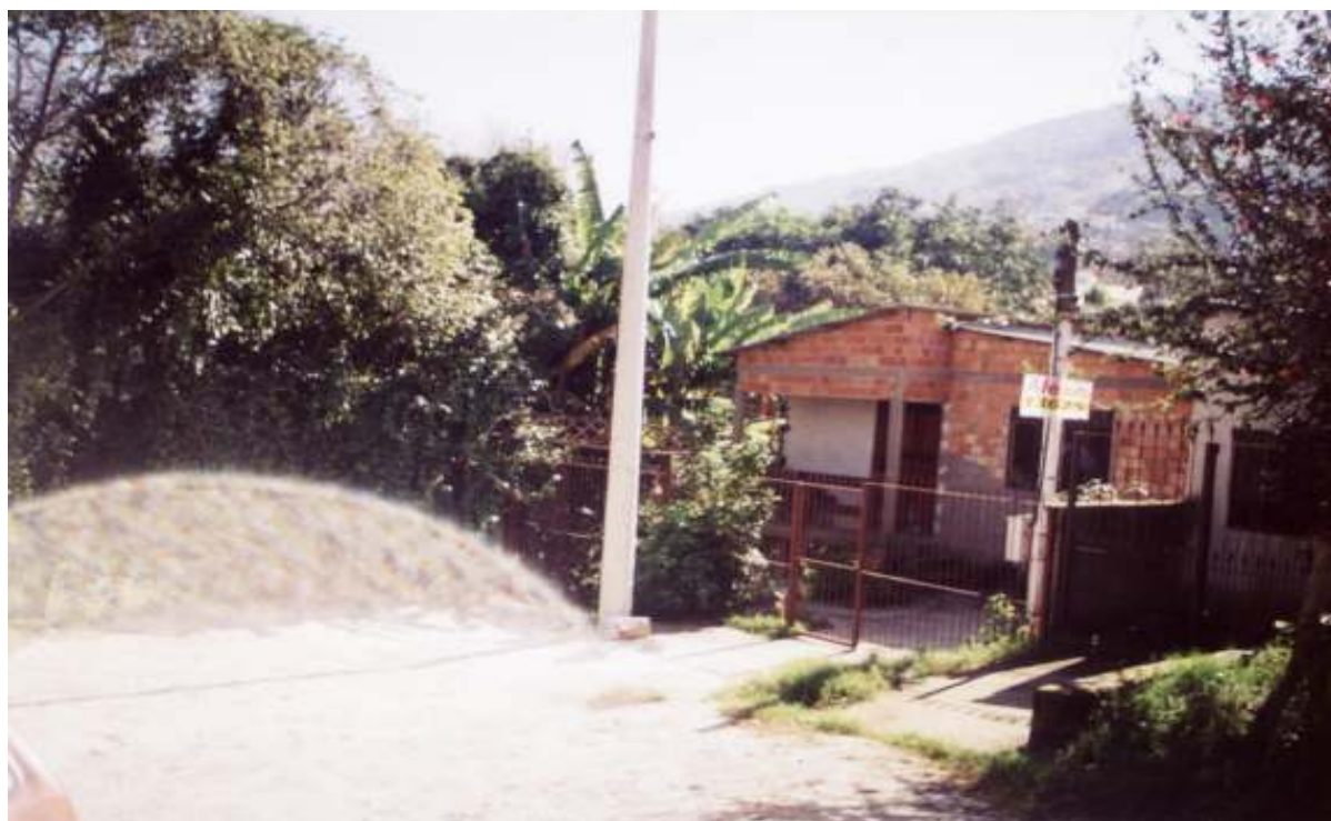
Figura 86. Casa de alvenaria de tijolos furados, sem revestimento, em razoável estado de conservação
