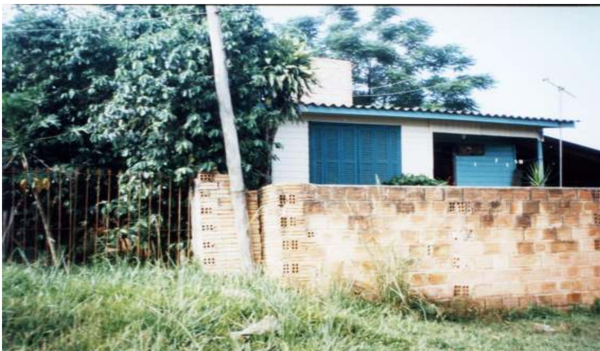
Figura 83. Casa de madeira, em bom estado de conservação
