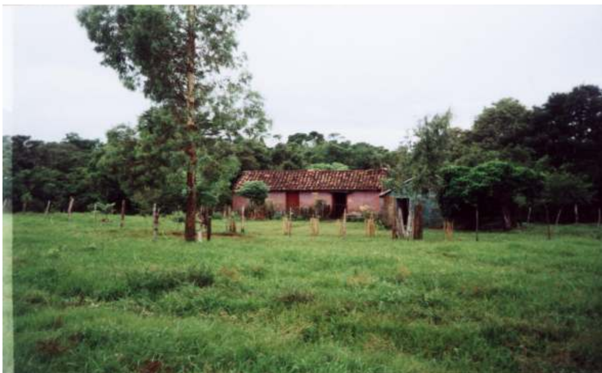
Figura 70. Casa de alvenaria de tijolos maciços e revestida com argamassa, em precário estado de conservação, devido à antiguidade da construção e falta de manutenção
