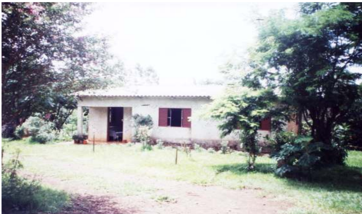
Figura 69. Casa de alvenaria de tijolos furados com revestimento de argamassa, mas sem pintura
