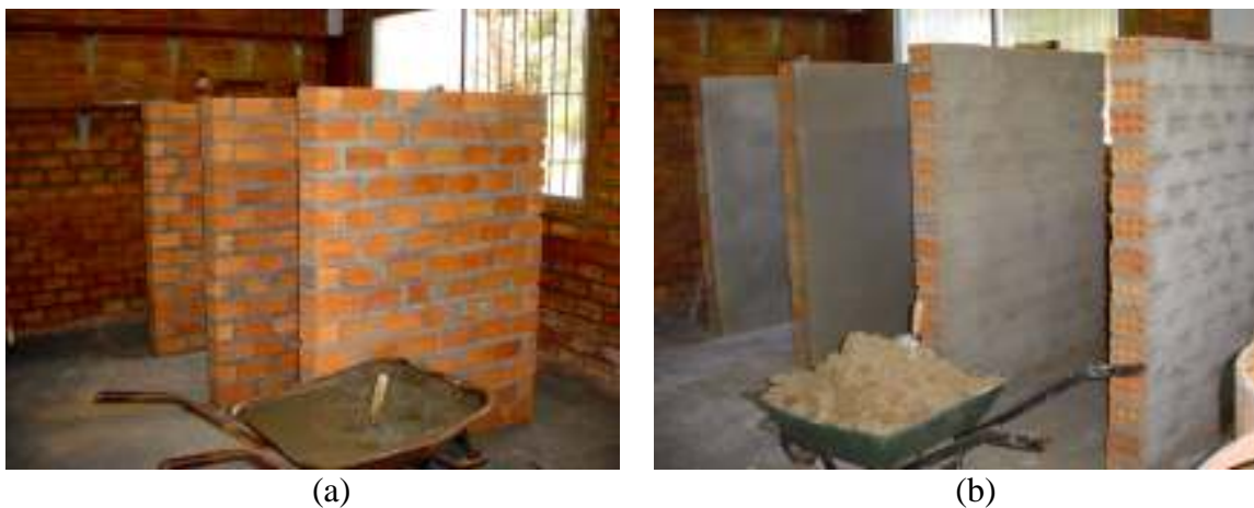
(a) (b) Figura 15: paredes de alvenaria a serem revestidas (a) antes da aplicação do chapisco; (b) após aplicação do chapisco
