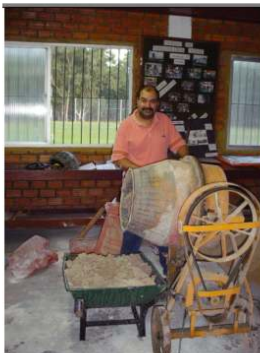
Figura 8: confecção da argamassa intermediária em betoneira de eixo inclinado
