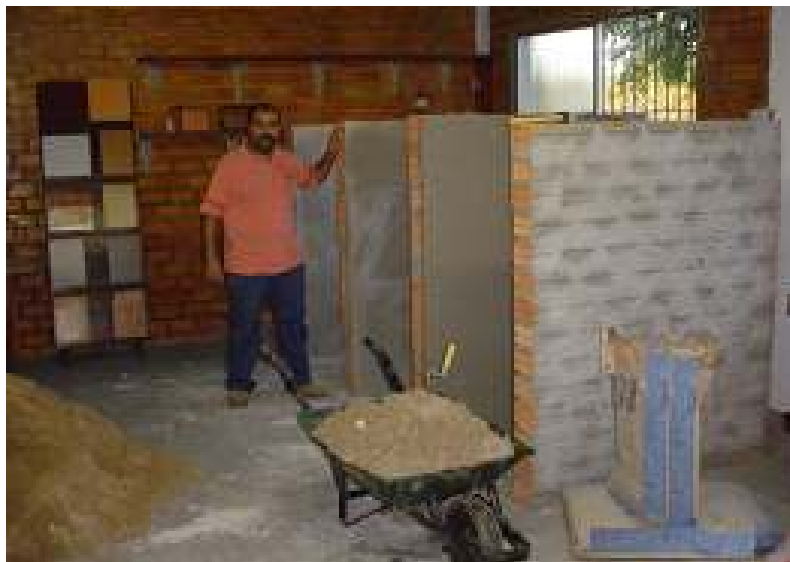
Figura 19: paredes de alvenaria com revestimento de argamassa, traço 1:2:9 com superfície previamente chapiscada
