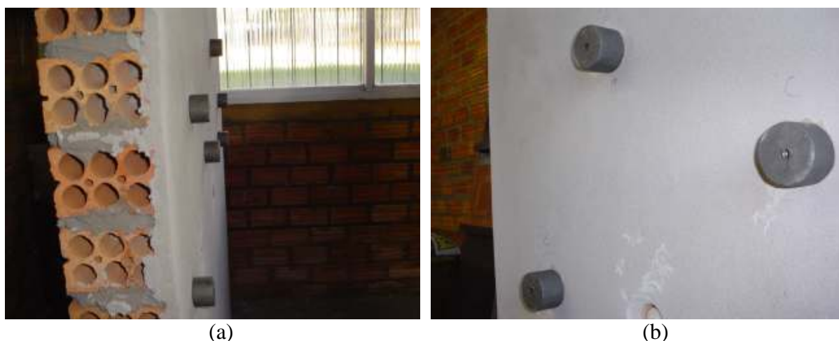
(a) (b) Figura 22: colocação das pastilhas cilíndricas para fixação do equipamento de tração (a) vista lateral; (b) vista frontal
