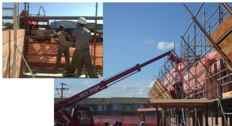
Figura 38: fotos da subutilização do manipulador telescópico para fornecer materiais aos pavimentos.
